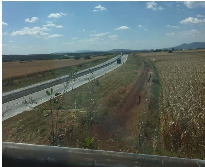
Ilustración 47.- Segmento por donde el gasoducto cruza el Libramiento Norte.
