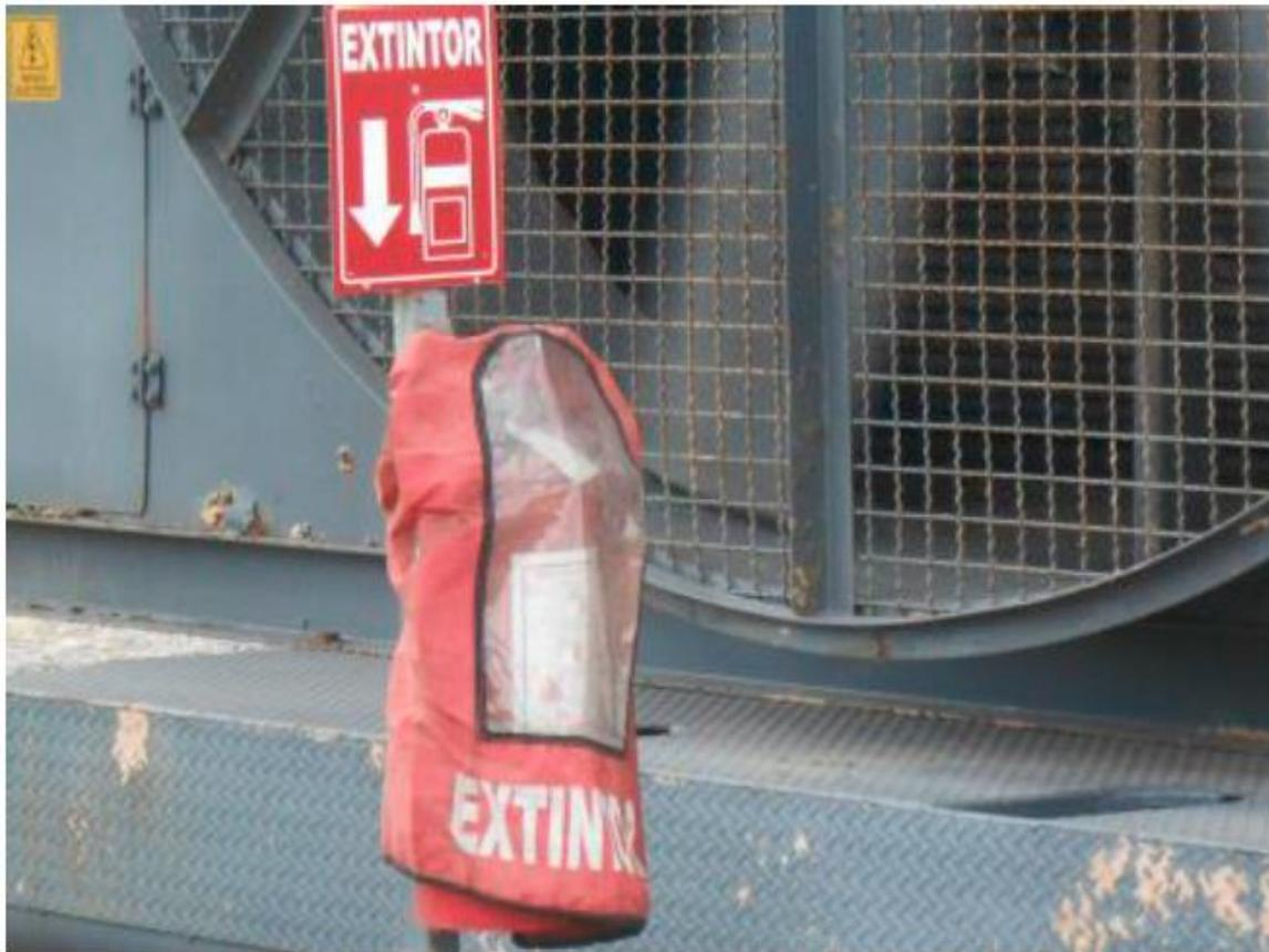
FIGURA 14 EXTINTOR COLOCADO EN EL ÁREA DE COMPRESORES.
