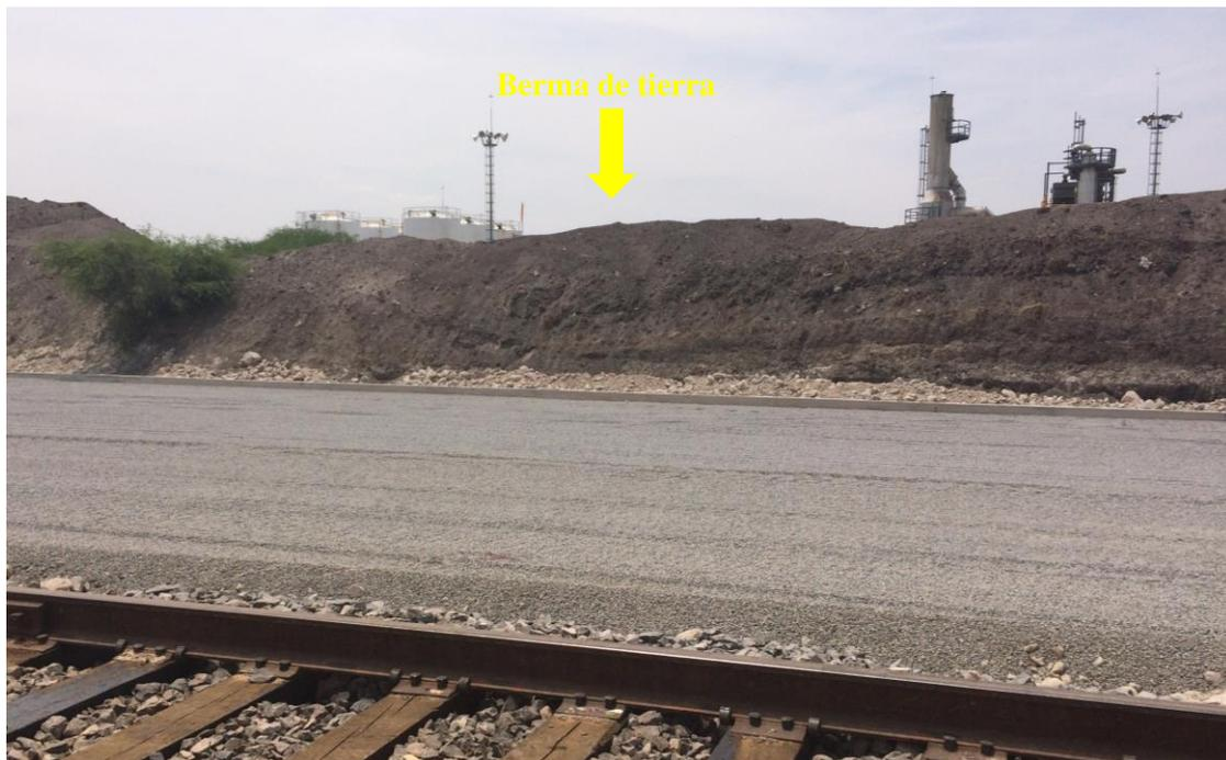
**Figura III.7 Barrera de protección; berma de tierra**
