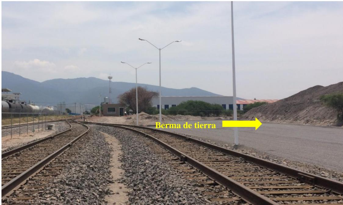
**Figura III.6 Barrera de protección; berma de tierra**
