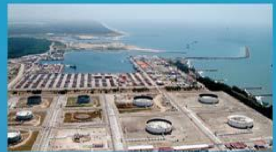
Terminal de Abastecimiento
