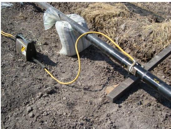
Una vez finalizada la soldadura, se realiza una radiografía de cada una de las uniones del ducto, así como en las soldaduras de la estación de medición y regulación del punto de interconexión, con un equipo especial que permite detectar la existencia de posibles defectos y repararlos antes de enterrar la tubería.
