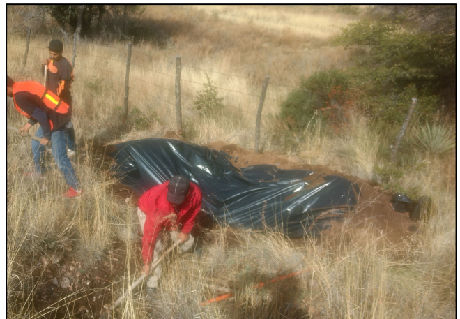
6.- Vista del bordo de contención.
