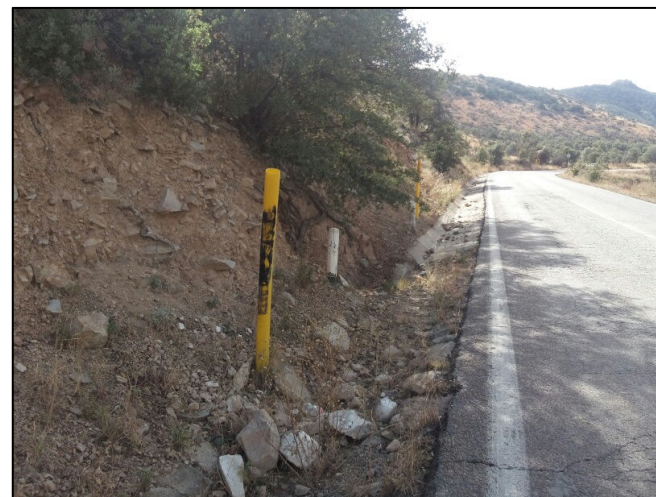
4.- Se observó la presencia de postería de fibra óptica en el sitio.
