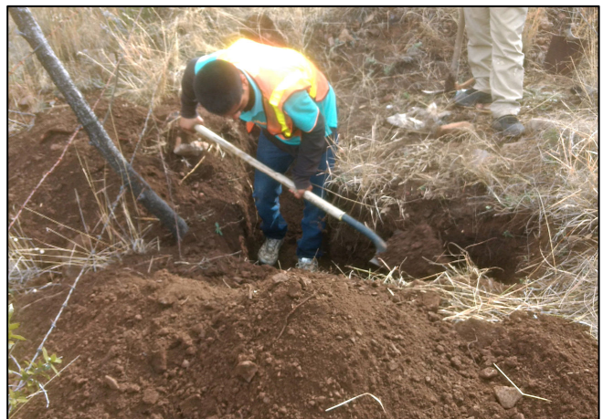
4.- Con apoyo de picos y palas se llevó a cabo la construcción de la zanja para delimitar el área.
