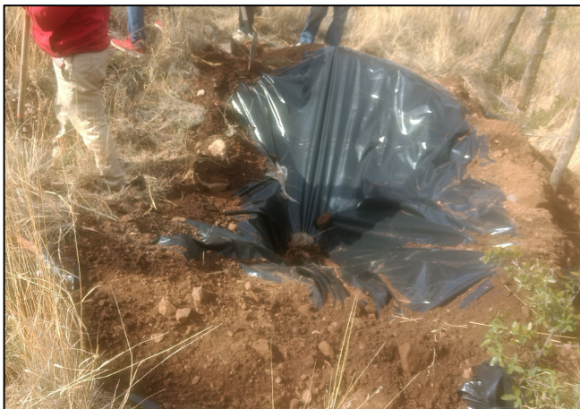
5.- Se cubrieron los bordos de la zanja con una membrana impermeable de polietileno de alta densidad.
