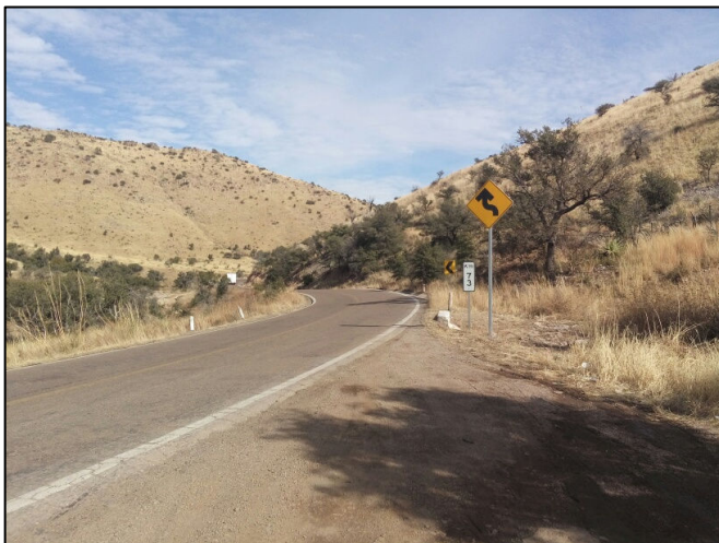
1.- Sitio del accidente en el Km. 73 + 200 de la Carretera Federal No. 02, Ascensión – Agua Prieta, tramo Janos – Puerto San Luis, municipio de Janos, estado de Chihuahua.
