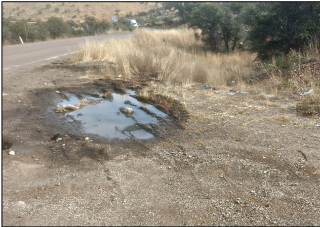
1.- Ubicación del sitio del accidente en el Km. 73 + 200 de la Carretera Federal No. 02, Ascensión - Agua Prieta, tramo Janos – Puerto San Luis, municipio de Janos, estado de Chihuahua.
