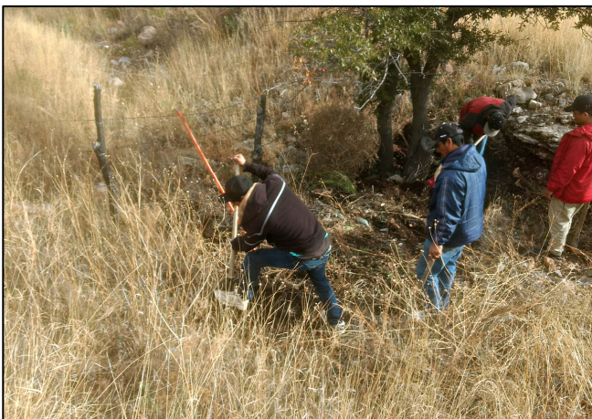
3.- Se inician los trabajos para la construcción de un bordo de contención.
