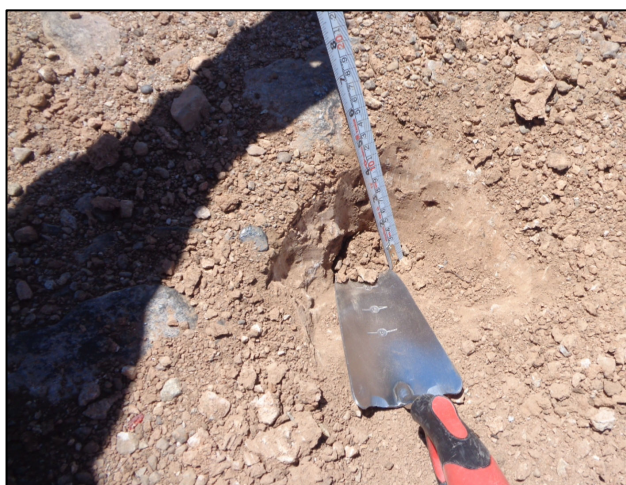
9. Toma de muestra testigo, con ayuda de espátula de acero inoxidable.
