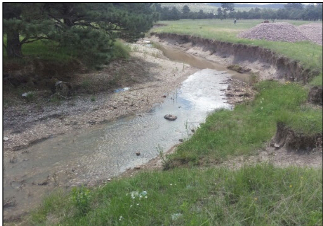
7.- El hidrocarburo se desplazó por el cauce del arroyo de temporal innominado.
