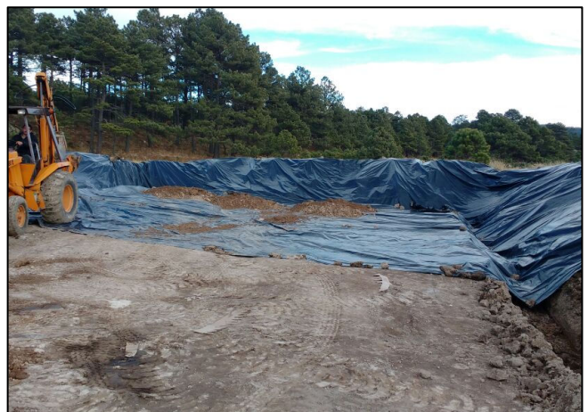
6.- Se cubrieron los bordos de la celda con la película de polietileno de alta densidad.
