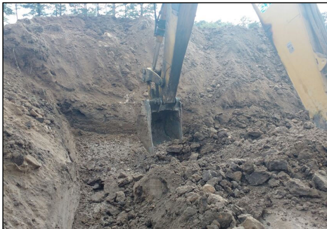
3.- Acondicionamiento del sitio para la construcción de la celda provisional.
