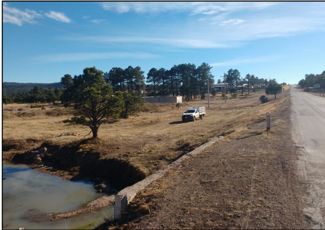
1.- Ubicación del sitio del accidente en el Km 58 de la Carretera Creel, en la entrada del Poblado San Juanito, municipio de Bocoyna, estado de Chihuahua.
