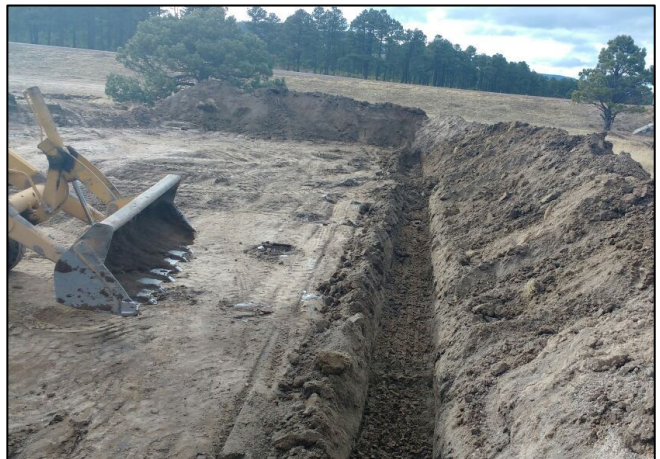
4.- Construcción de la celda provisional con retroexcavadora.
