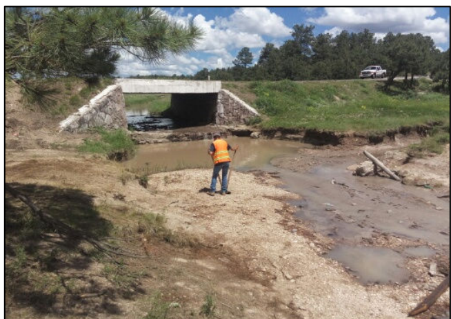
11.- Se realizaron sondeos en el cauce del arroyo de temporal innominado.
