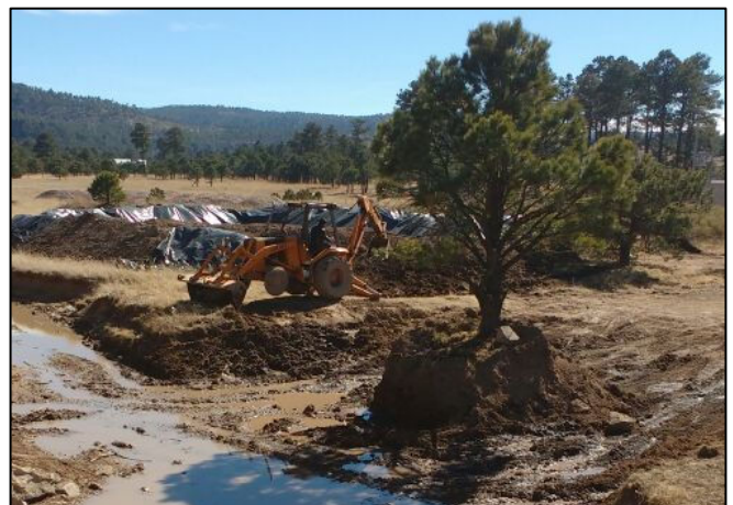
12.- Vista panorámica de la fosa de excavación y de la celda provisional.
