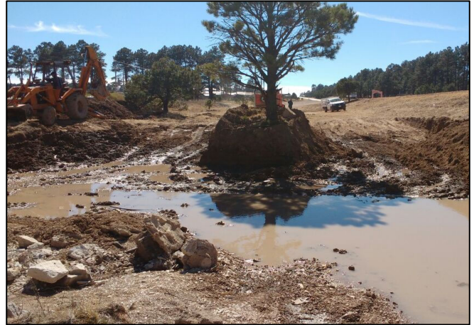
8.- Con apoyo de maquinaria pesada, se realizó la extracción del material edáfico afectado.
