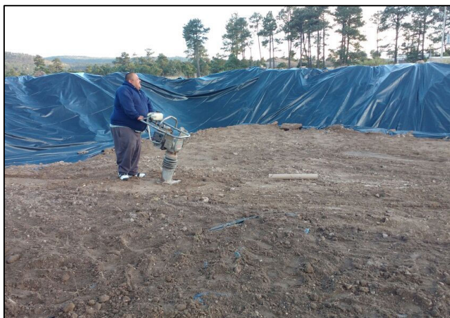
5.- Compactación de suelo dentro de la celda provisional.
