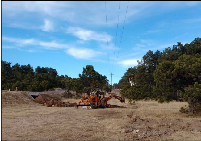
7.- Extracción del material edáfico afectado con Diésel de la fosa de excavación.
