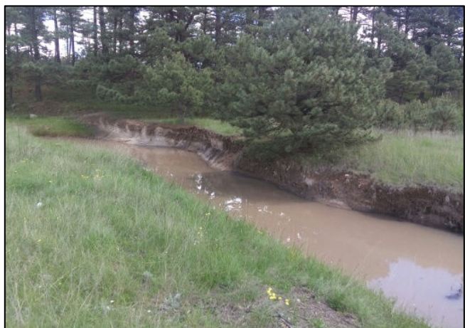
9.- El arroyo pasaba a un lado de diversos predios particulares existentes en la zona.
