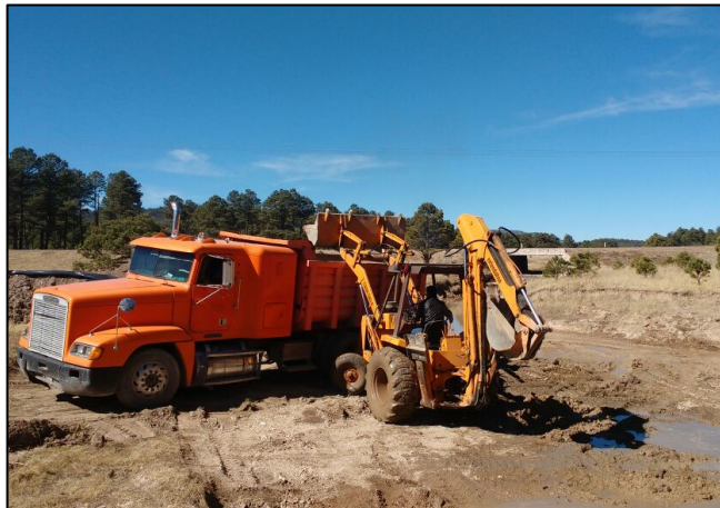
9.- El material edáfico afectado se depositó en un camión de carga con ayuda de maquinaria pesada.
