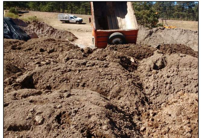
10.- Acarreo y depósito de material edáfico afectado en celda provisional con ayuda de camión de volteo.
