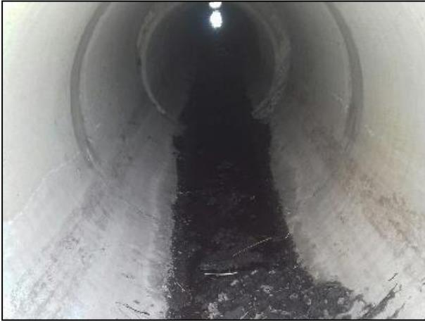
7.- Limpieza de la superficie de concreto afectado por el Combustóleo.
