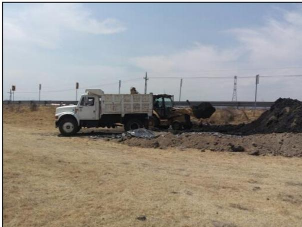
9.- Con apoyo del camión de volteo se acarrió del material edáfico afectado con Combustóleo en celdas provisionales.
