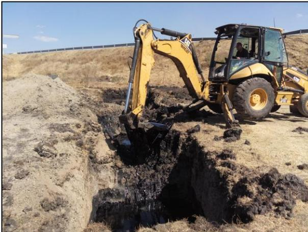
3.- Extracción del material afectado con Combustóleo, con ayuda de maquinaria pesada (retroexcavadora).
