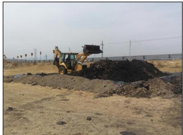
10.- Con apoyo de maquinaria pesada (retroexcavadora) se depositó el material edáfico afectado con Combustóleo en celdas provisionales.
