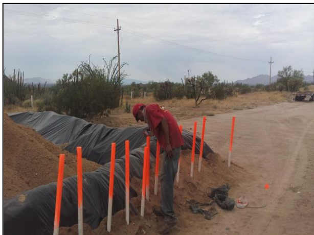
11.- Señalización preventiva de la zona de trabajo (celda provisional).
