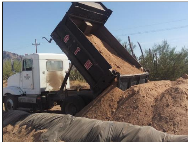
10.- Deposito de material edáfico afectado en celda provisional con la ayuda de camión de volteo.
