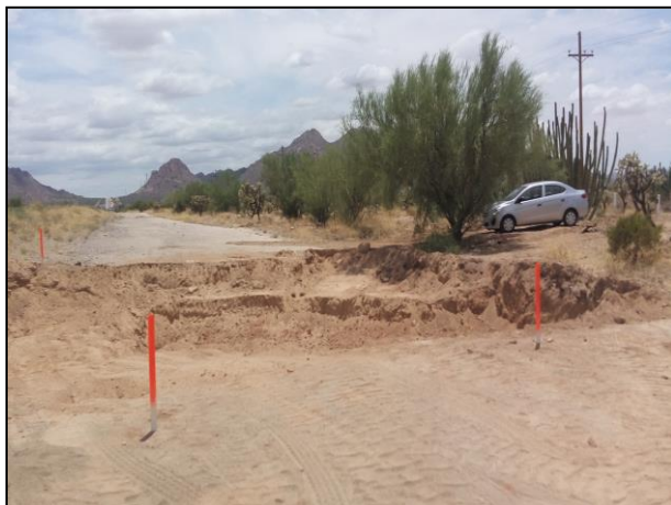
12.- Señalización preventiva de la zona de trabajo (fosa de excavación).
