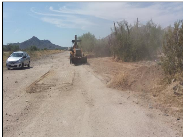
2.- Acondicionamiento del sitio en el cual se construirá la celda provisional.
