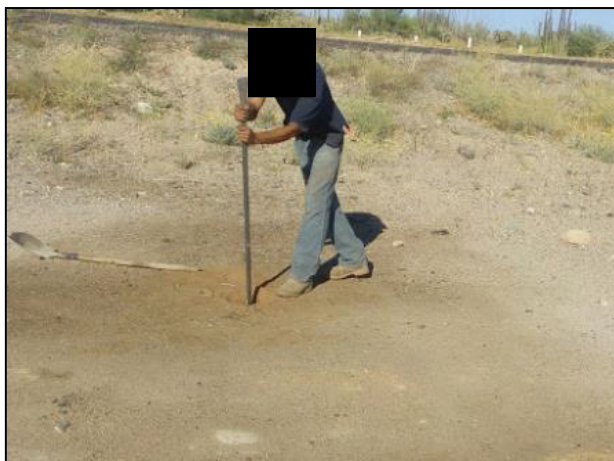
3.- Con apoyo de una barra de acero se realizaron sondeos para determinar la pluma del contaminante.
