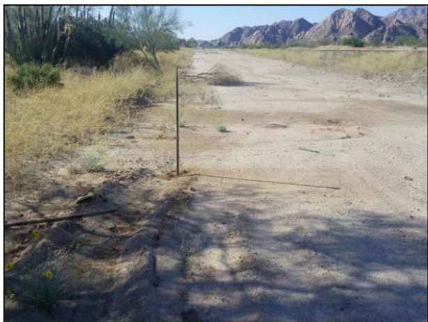
1.- Sitio del accidente en el Km. 228+800 de la carretera Altar – Sonoyta, municipio General Plutarco Elías Calles, estado de Sonora.
