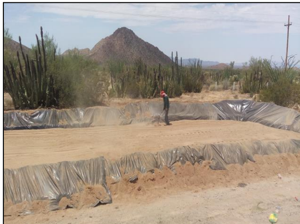
7.- Compactación de la capa de arcilla con ayuda de un vibrocompactador manual.
