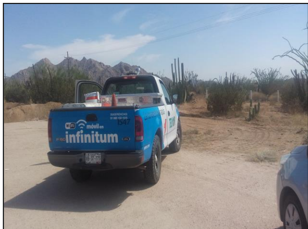
1.- Personal de Telmex llega al sitio para indicar el paso de fibra óptica.
