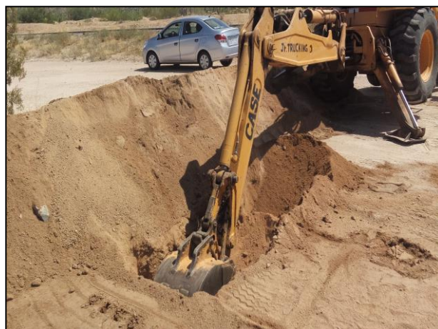
4.- Construcción de canaletas de captación de lixiviados de la celda provisional con ayuda de la retroexcavadora.
