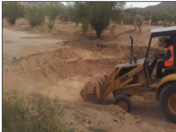
8.- Extracción del material edáfico afectado con Diésel con apoyo de la retroexcavadora.
