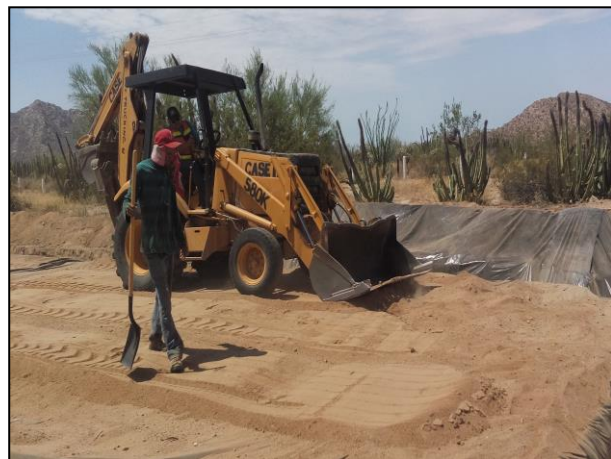
6.- Se colocó una capa de arcilla sobre la película de polietileno de alta densidad para aumentar la impermeabilidad de la celda provisional.
