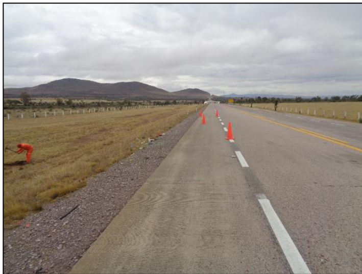
1. El sitio fue debidamente señalado con conos naranjas, delimitando el área de trabajo.
