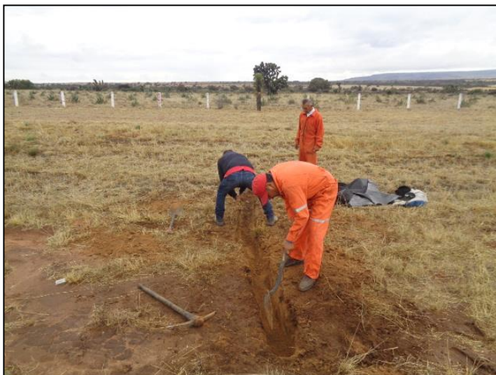
3. Se realizó la excavación de manera manual para colocar la película de polietileno de alta densidad y así sí evitar la migración del hidrocarburo.
