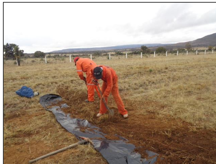
4. Colocación de película de polietileno de alta densidad utilizada como barrera de contención.
