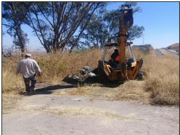
4 – Con apoyo de maquinaria pesada se procedió con la extracción de material edáfico afectado.
