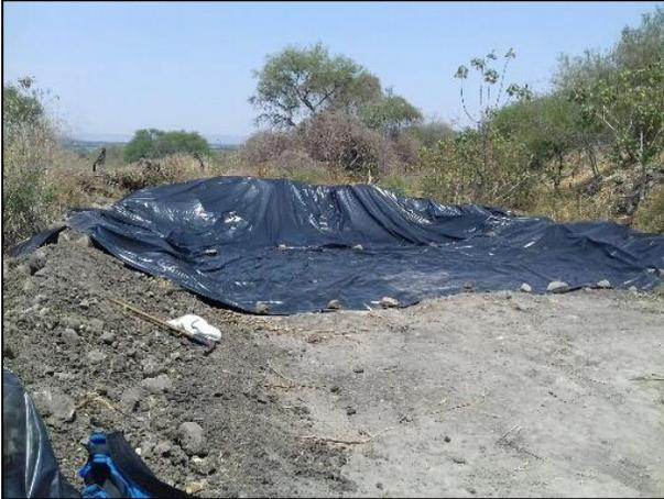
7 – Película de polietileno de alta densidad colocada en la zona de la celda provisional.
