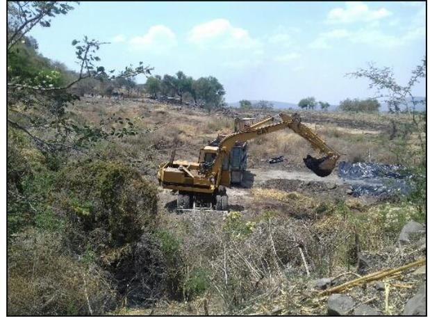
20 – Extracción del suelo dañado en el ÁREA 3 (llano) con apoyo de maquinaria pesada.
