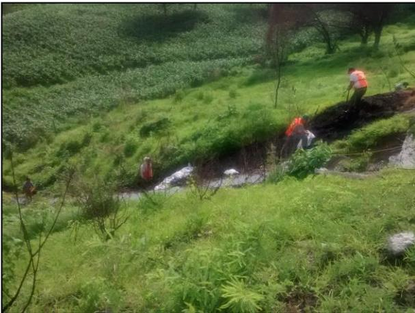
15 – El suelo dañado con Combustóleo del ÁREA 2 (ladera) fue extraída con apoyo de recurso humano utilizando palas y picos.
