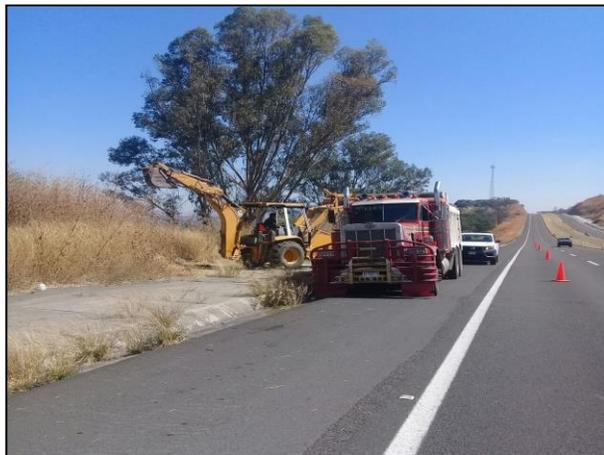
3 – Apoyo de maquinaria pesada para la extracción de material y de camión de carga para el traslado a la celda Provisional.
