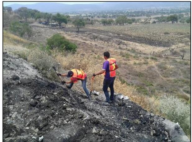
10 – Con apoyo de recurso humano utilizando palas y picos, se realizó el raspado de la capa superficial de Combustóleo en el ÁREA 1.
