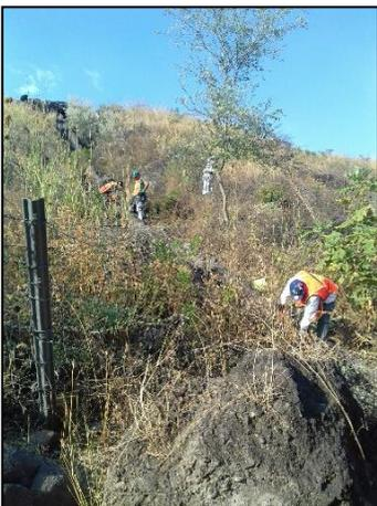
11 – Extracción de suelo dañado en el ÁREA 2 (ladera) a un lado de la canaleta de concreto.
