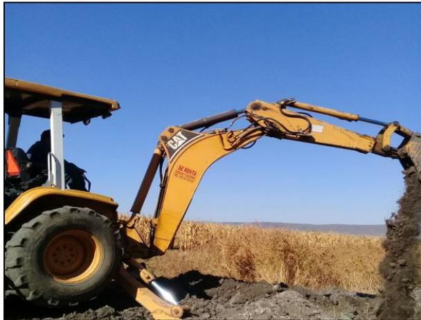
9 – Homogenización de material edáfico depositado en Celda de Tratamiento.
