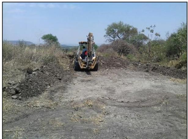
6 – Construcción de los bordos de la celda provisional.
