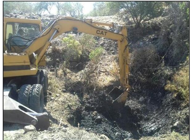
22 – Con ayuda de retroexcavadora se retiró el suelo afectado (dañado) con Combustóleo.
