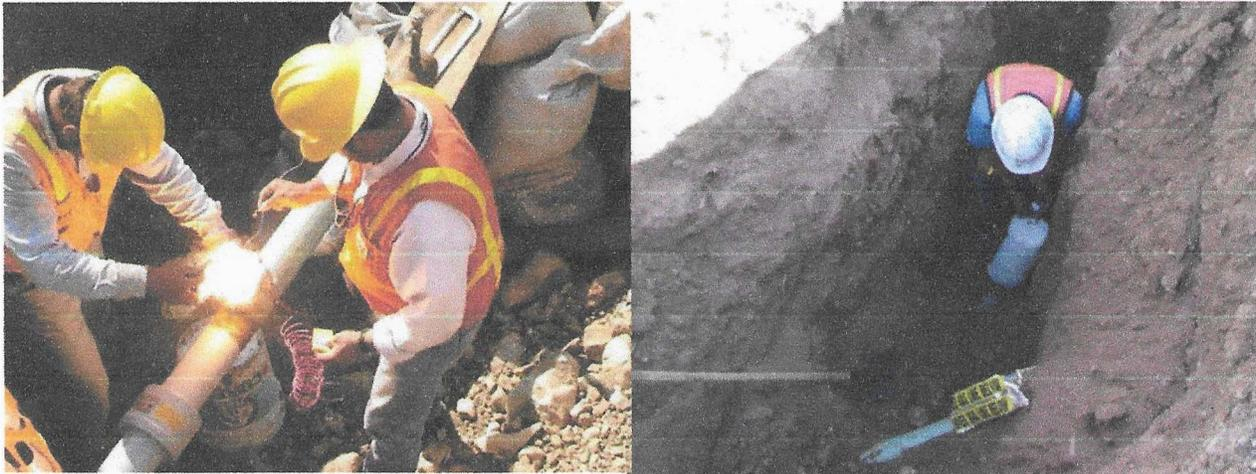
*Instalación del sistema de protección contra la corrosión en el gasoducto*
