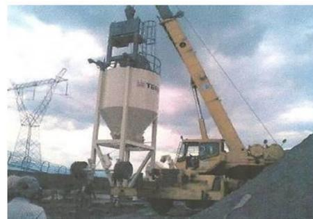
Figura 26. Instalación de la planta de asfalto.
