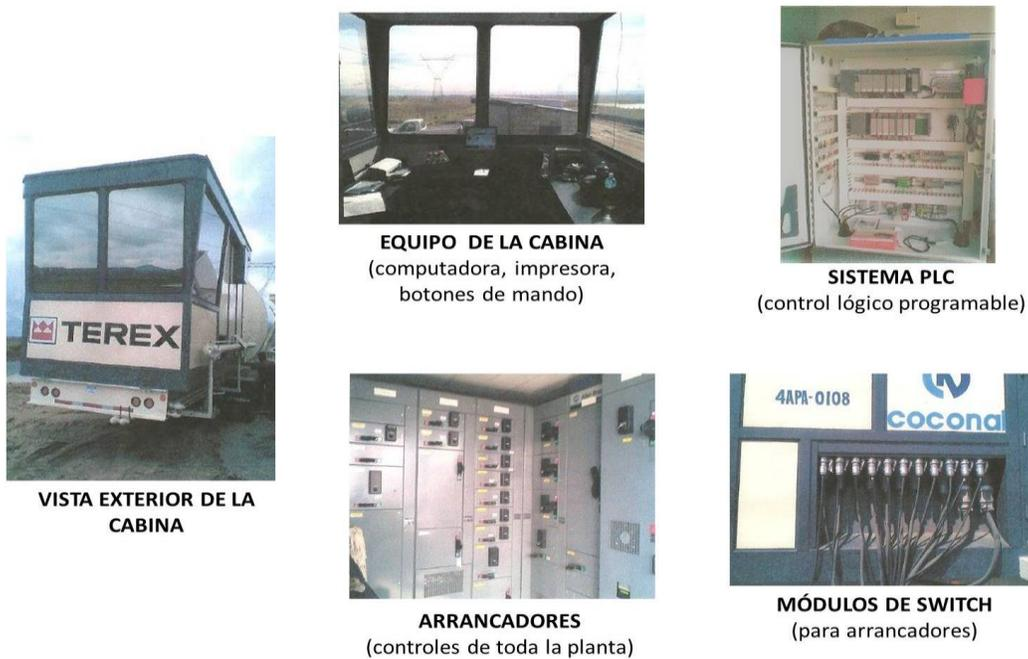
Figura 19. Componentes de la cabina de control de la planta de asfalto.
