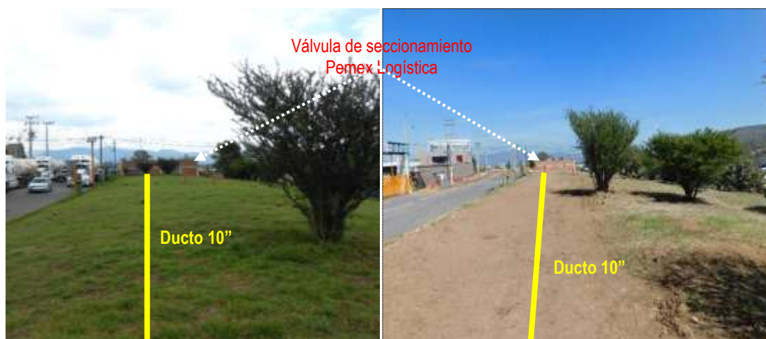
Figura II.4. Instalación del ducto nuevo de 10"Ø sobre la trayectoria del gasoducto de Cactus-Guadalajara hasta el punto de inflexión hacia el terreno de las instalaciones de INVALLE, S.A. de C.V.
