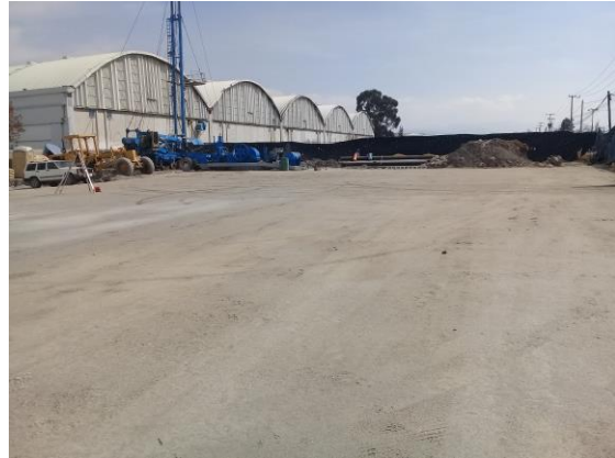
Ilustración 13. Vista hacia el Interior del Predio del Proyecto, donde se observa el límite del predio de la Delimitación parcial del área ocupada por la losa, mediante malla ciclónica de acero galvanizado con altura de 2 m.
