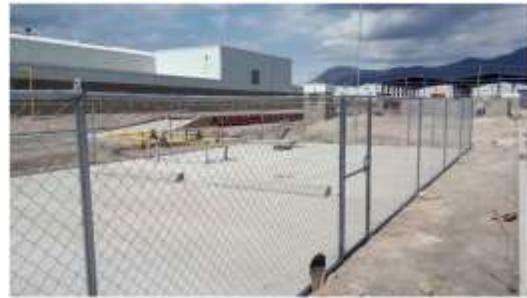
*Ilustración 30. Vista hacia el Interior del Predio del Proyecto, donde se observa el limite del predio de la Planta, y la Delimitación parcial del área ocupada por la losa, mediante malla ciclónica de acero galvanizado con altura de 2 m, como se describe en el apartado I.1.1. Proyecto civil*
