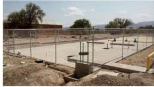
*Ilustración 28. Vista desde el Exterior del predio del proyecto con dirección NNE-SO. Se observa la Delimitación parcial del área ocupada por la losa, mediante malla ciclónica de acero galvanizado con altura de 2 m, como se describe en el apartado I.1.1. Proyecto civil*
