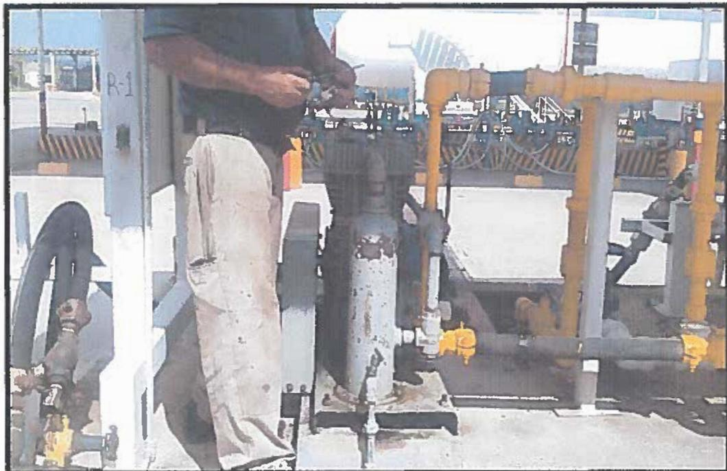
Purgar el compresor para verificar que en la línea de vapores no exista líquido.
