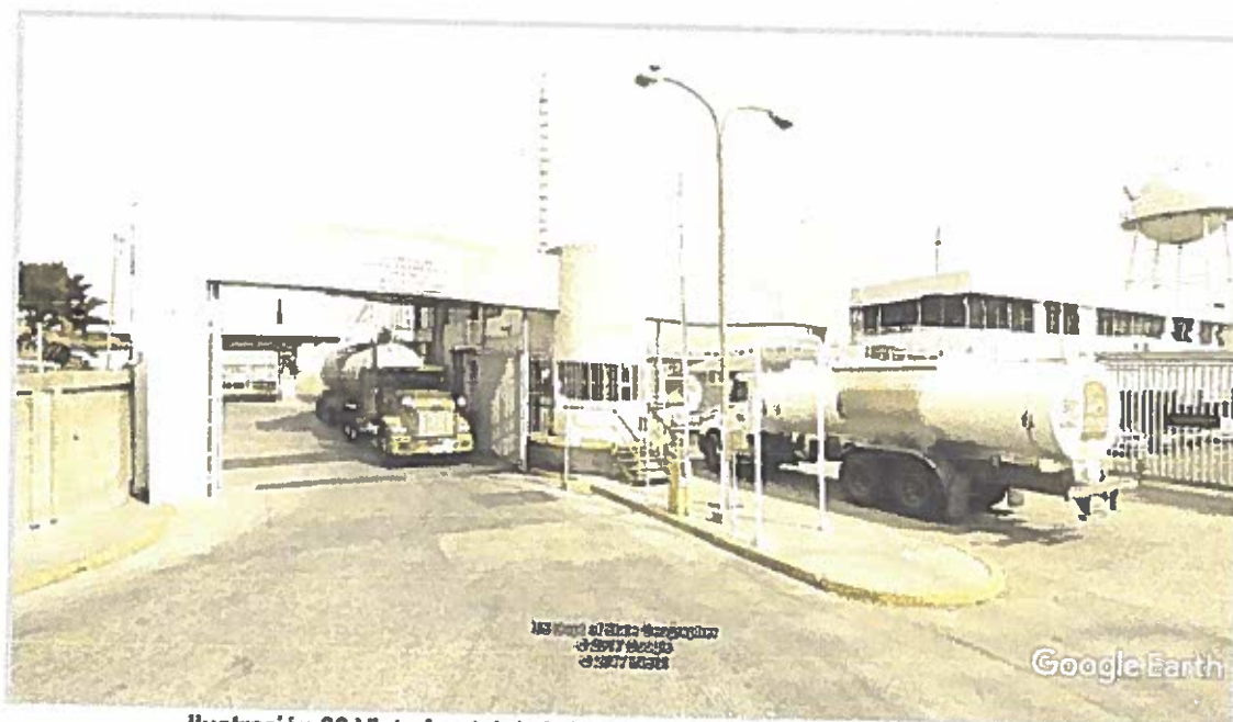
Ilustración 33 Vista frontal de la Terminal de Almacenamiento y Reparto
