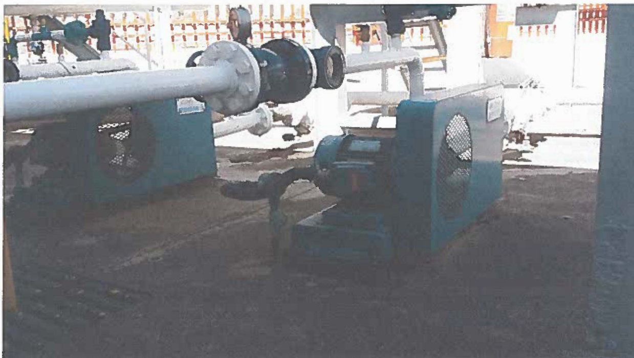
Foto 8 Arreglo de Bombas de la estación.
