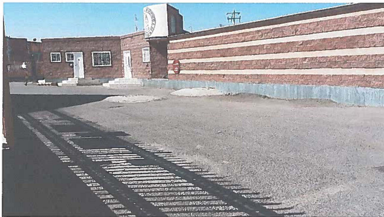
Foto. 2 Vista de las condiciones ambientales al interior de la estación.
