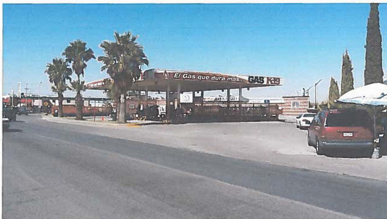
Foto 1 Vista general de la estación de carburación se aprecian las áreas de acceso principal y al fondo el área de operaciones, al frente las áreas de circulación.
