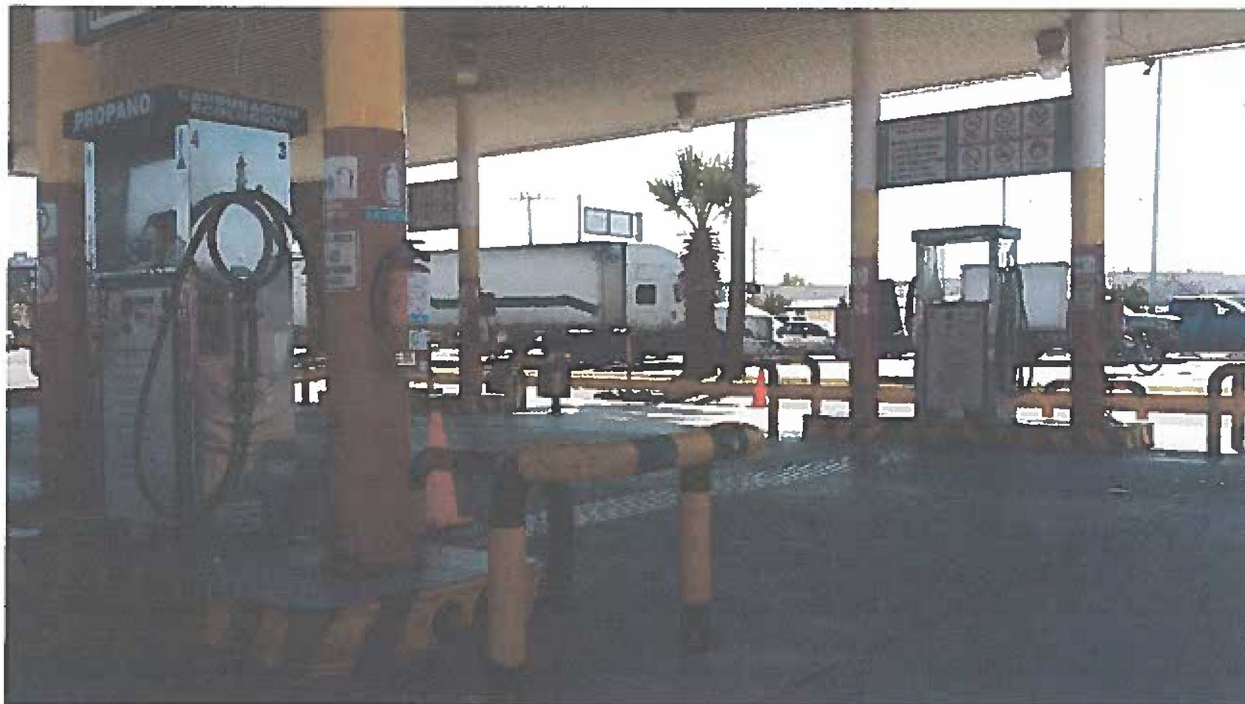
Foto 4 Medios de protección en zona de suministro.
