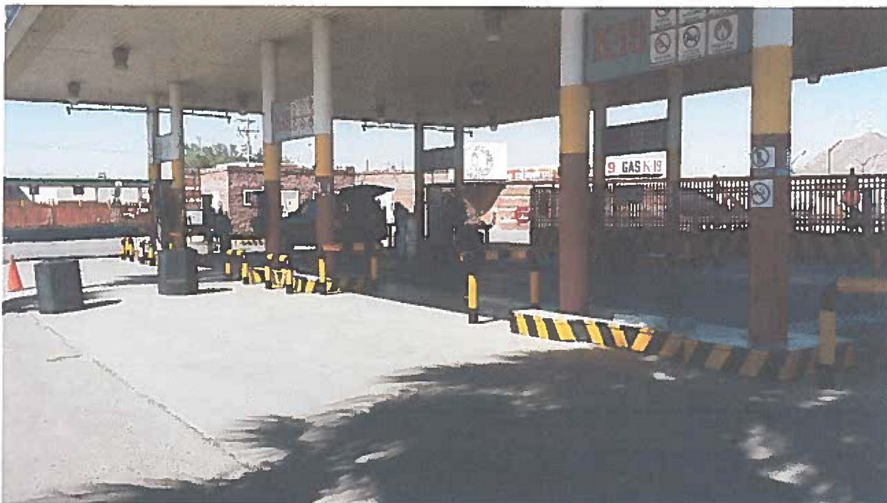
Foto. 3 Vista de las condiciones ambientales al interior de la estación.
