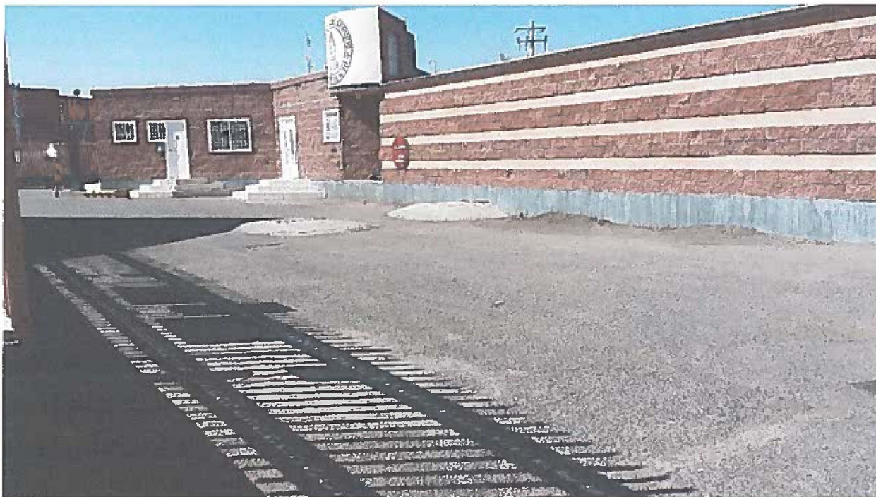
Foto 2 Vista de las edificaciones de la Estación de Carburación.
