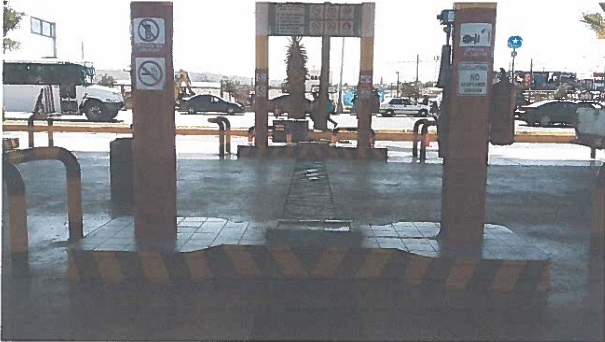
Foto 5 Trincheras en zona de suministro.
