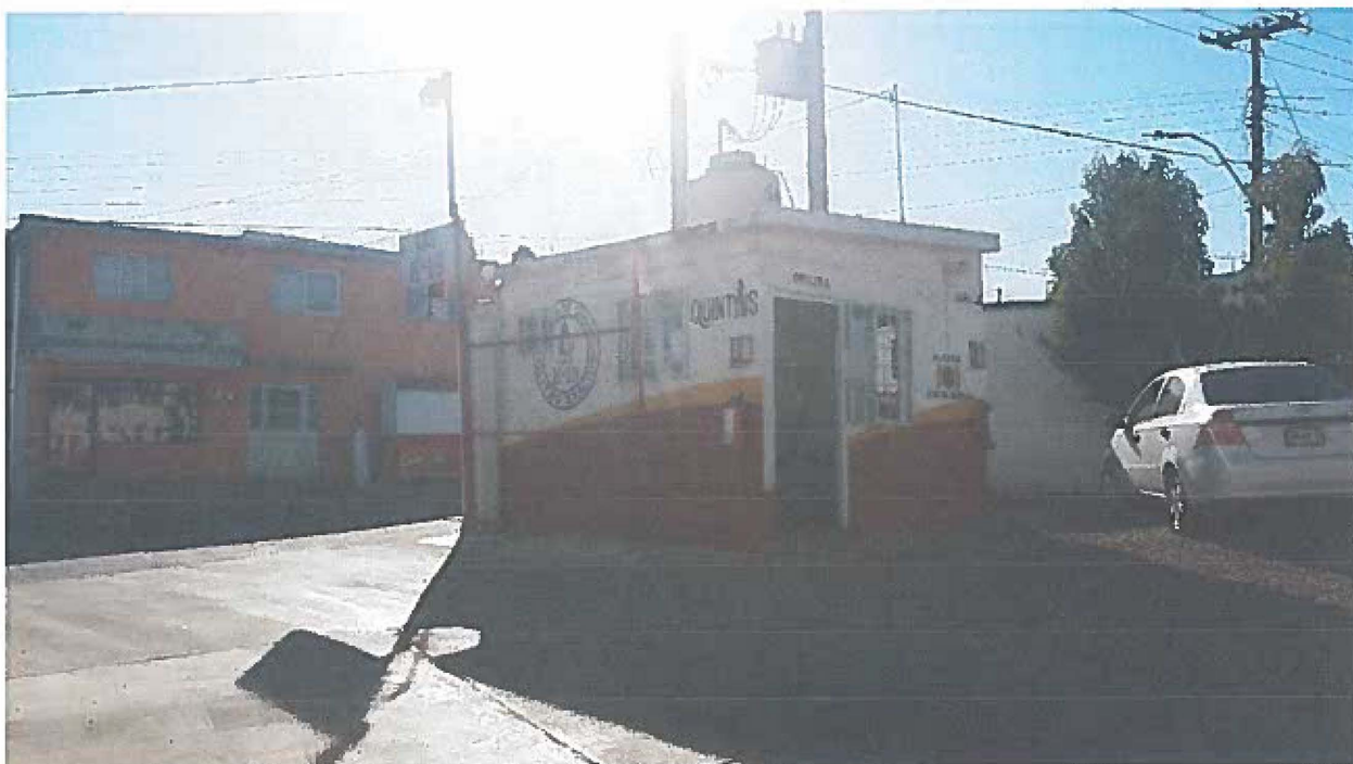
Foto. 2 Las entradas están consolidadas con pisos de cemento.
