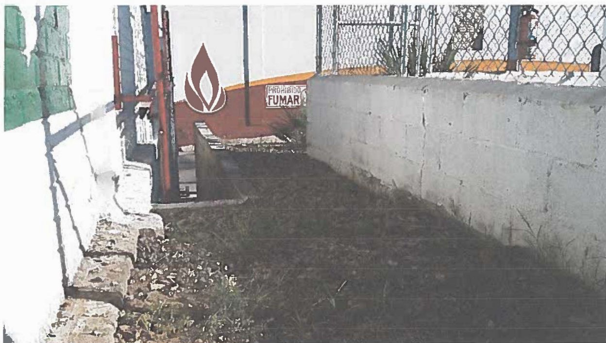
Foto. 3 En la zona de almacenamiento se han conservado pequeñas superficies con tierra vegetal para favorecer el crecimiento del estrato herbáceo.
