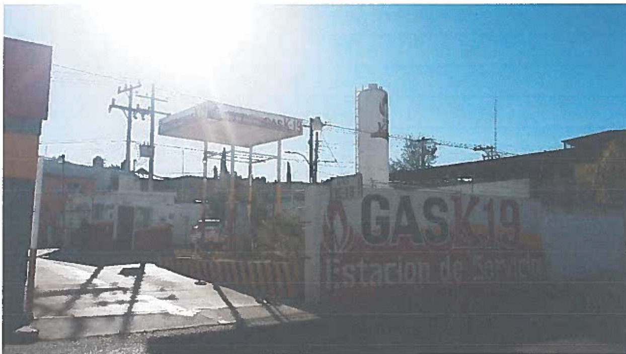
Foto 1 Vista general de la Estación de Carburación.
