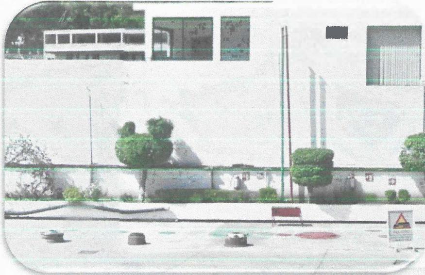
Fotografía 2. La Estación de servicio E5024 cuenta con áreas verdes en la zona periferal de la misma, se observan los tubos de venteo y el área de tanques de almacenamiento.
