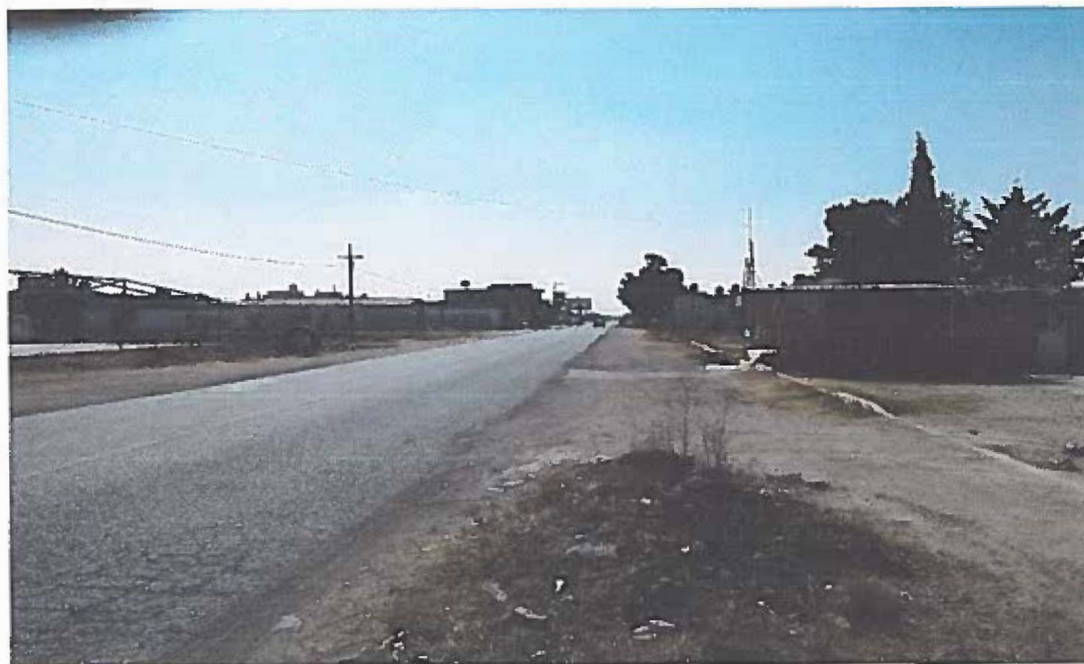
Figura 23. Vista del entorno de la estación.
