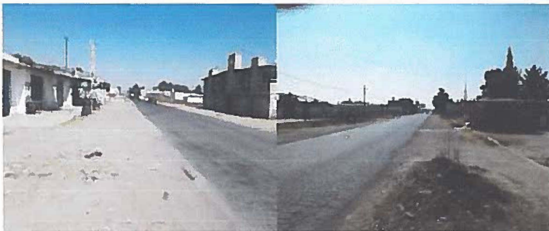
Figura 13. Entorno de la zona donde se realizó el proyecto.
