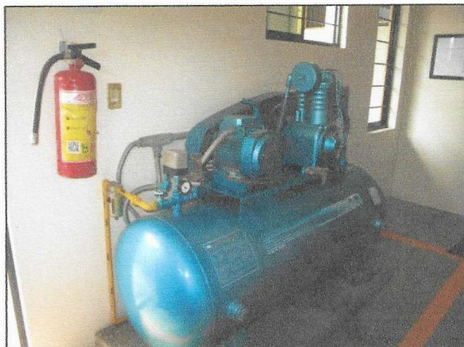
**Fotografía 9.-** Compresor de aire de 5 HP y capacidad de 500 lts, ubicado en el cuarto de control eléctrico y de máquinas.
