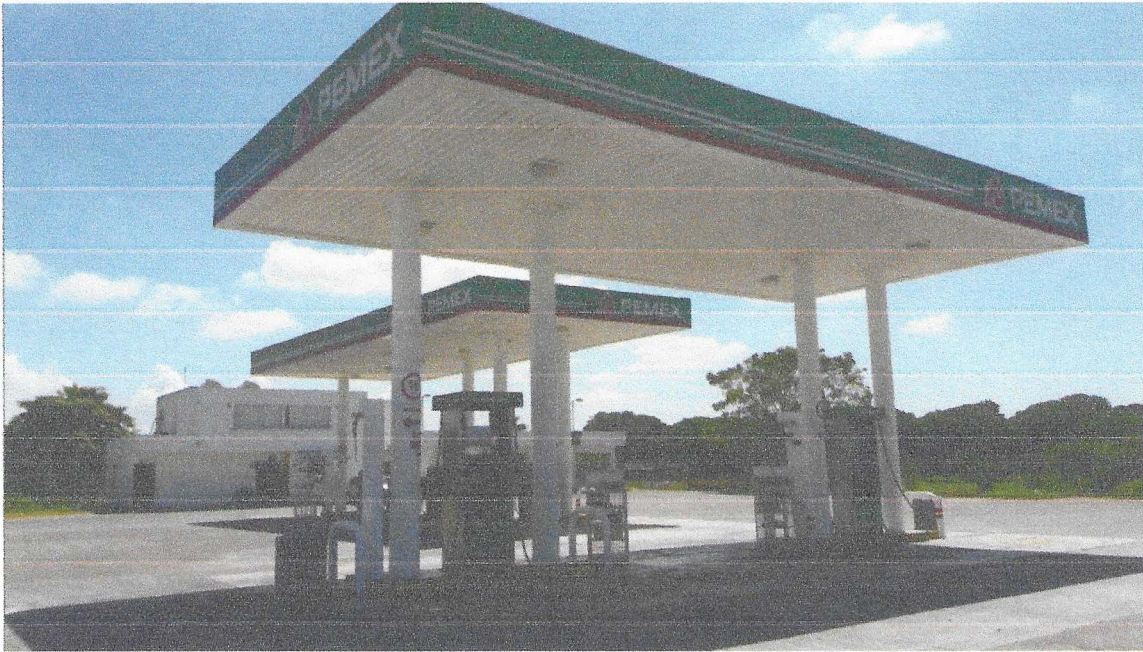
Fotografía 1. Estación de servicio 9193
