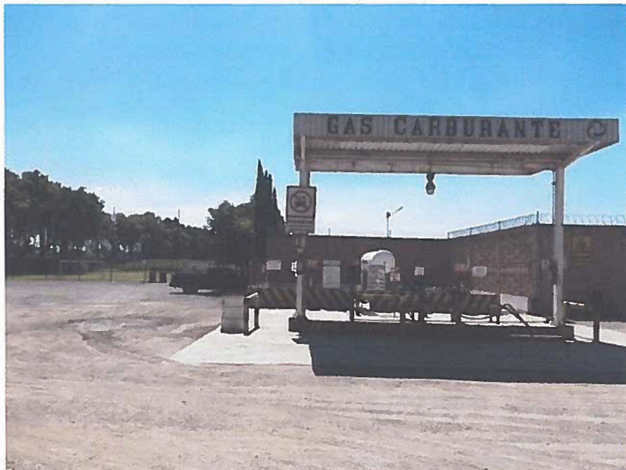
Figura 5. Vista del predio donde se construirá la Estación de Carburación Progreso.
