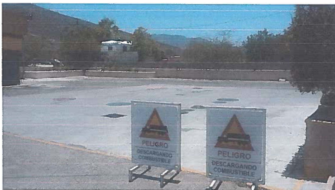
Fotografía 6. Señalización en zona de tanques de almacenamiento.
