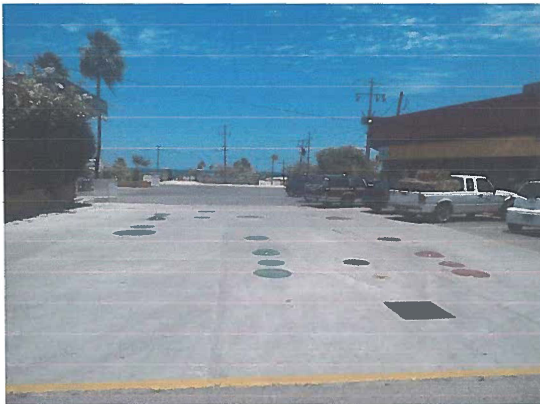
Fotografía 4. Zona de tanques de almacenamiento.
