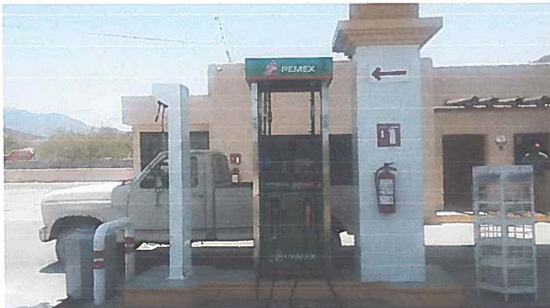
Fotografía 2. Zona de Despacho.
