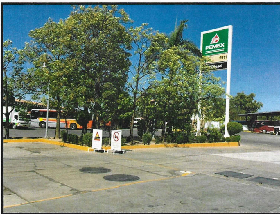
Figura 3.6 Área de tanques subterráneos
