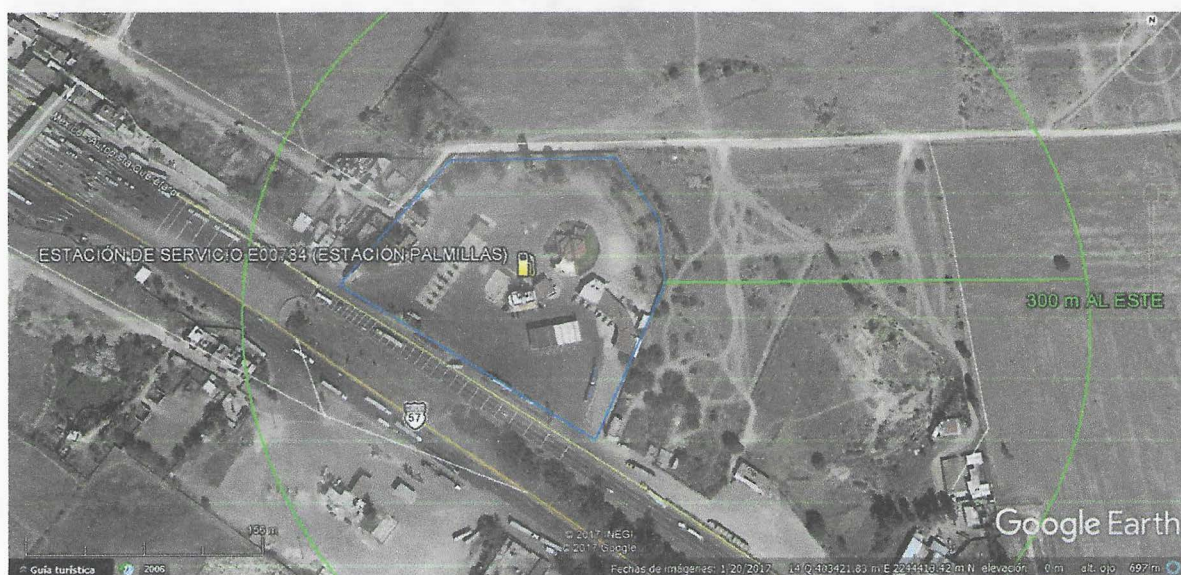
Figura 17. Infraestructura existente y colindancias a 300 m al ESTE, de la "Estación de Servicio E00874" (ESTACIÓN PALMILLAS).
