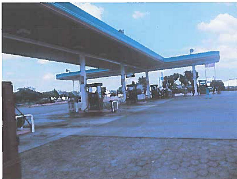
Dispensarios de la Estación de Servicio 5089.
