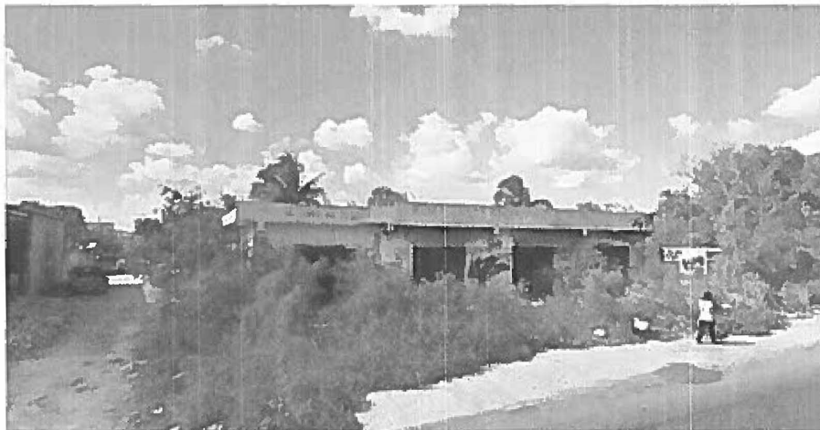
FOTOGRAFÍA 6. LOCALES SIN USO A 175 MTS. AL ESTE
