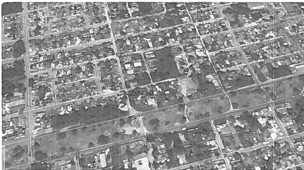
FIGURA 31. IMAGEN SATELITAL DE LA ESTACIÓN DE SERVICIO. FUENTE: GOOGLE EARTH
