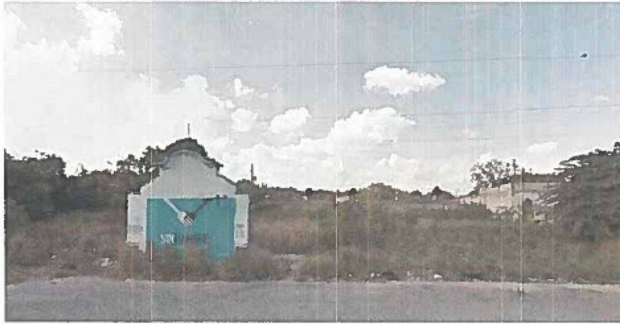
FOTOGRAFÍA 16. PREDIO VACIO A 222 MTS. AL OESTE
