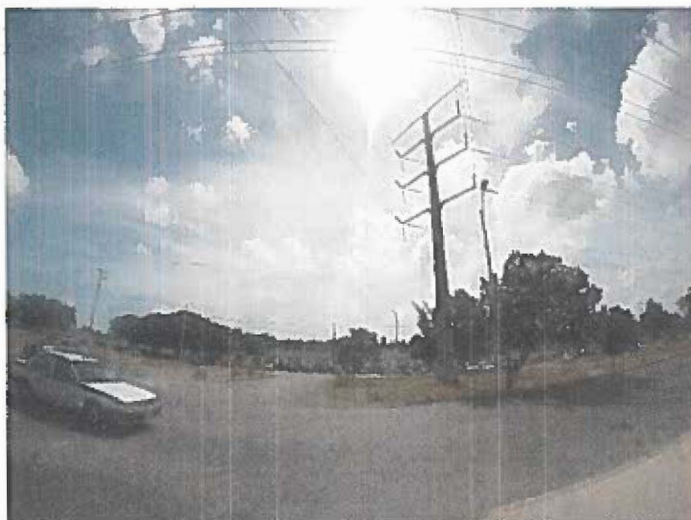
FOTOGRAFÍA 37. RED ELÉCTRICA DE ALTA TENSIÓN FRENTE AL SITIO DEL PROYECTO FUENTE: AP CONSULTORES 2017
