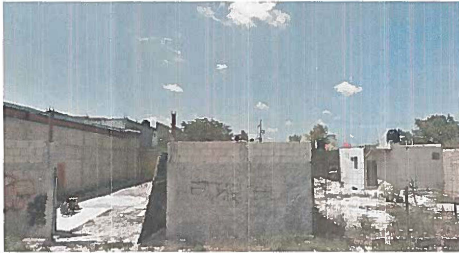
FOTOGRAFÍA 13. PREDIOS A 465 MTS. AL ESTE
