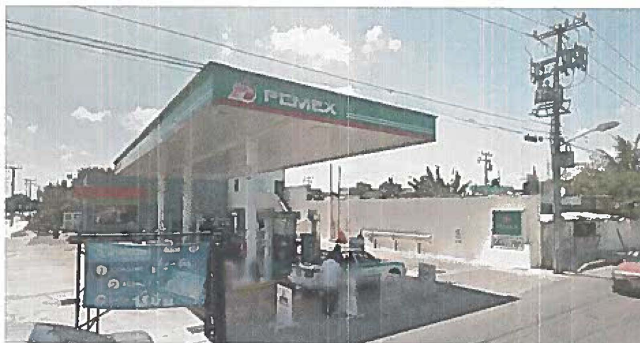
FOTOGRAFÍA 10. ESTACIÓN DE SERVICIO 11327 A 335 MTS. AL ESTE
