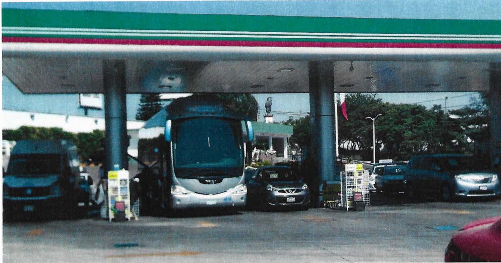
FIGURA 8. ZONA DE DESPACHO DE LA E.S. 11374
