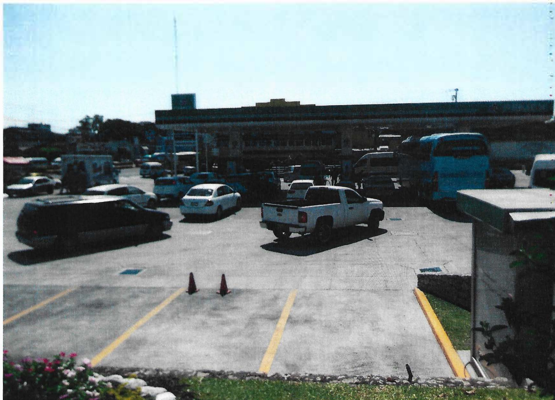
FIGURA 9. ESTADO ACTUAL DE LOS PISOS DEL ÁREA DE CARGA DE COMBUSTIBLE DE LA E.S. 11374
