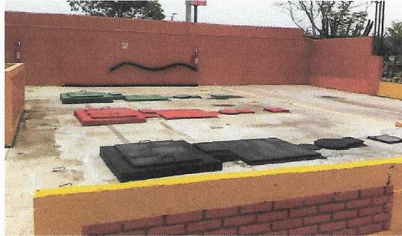
**FOTOS 3.** En esta foto se observa el área de tanques, en el que se tienen confinados los tres tanques de almacenamiento de diferentes colores: verde donde se almacena gasolina Magna, rojo donde se almacena gasolina Premium y negro donde se almacena el Diésel.
