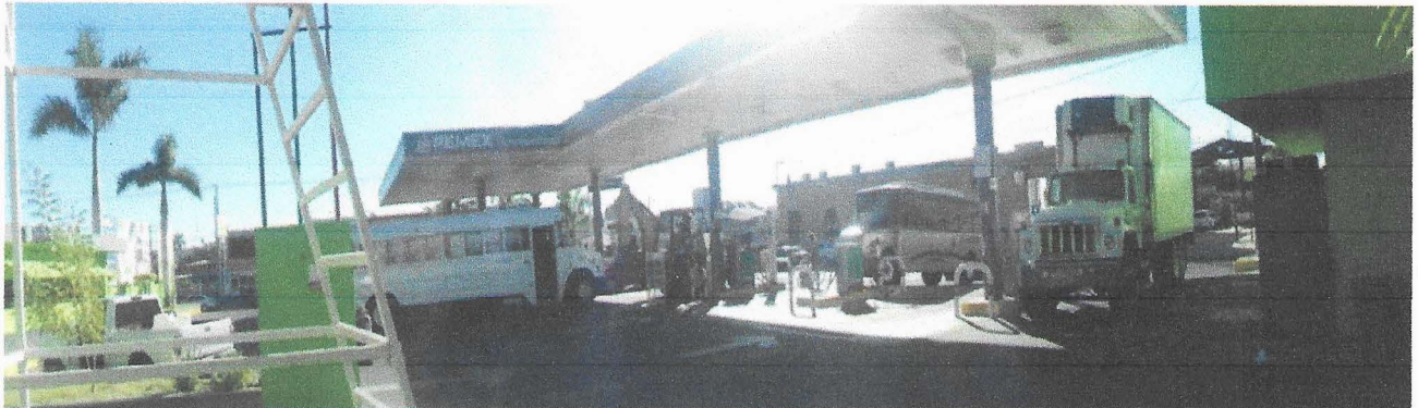
Imagen paronímica de la estación de bombas en funcionamiento.
