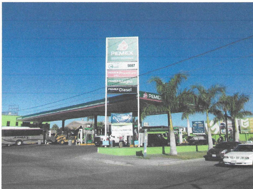
Se observa en el frente de la gasolinera con el espectacular que indica el número de la estación
