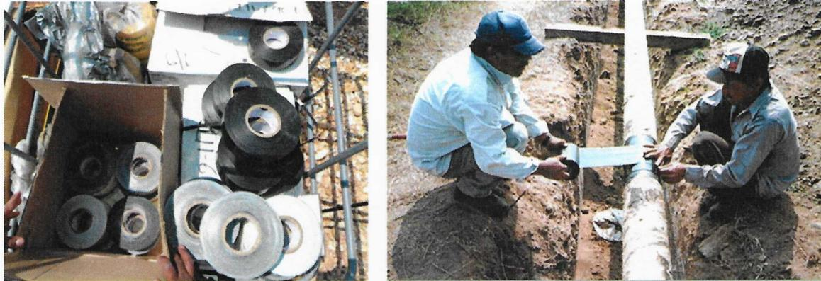
**Figura II-24. Recubrimiento externo de la tubería del gasoducto**
