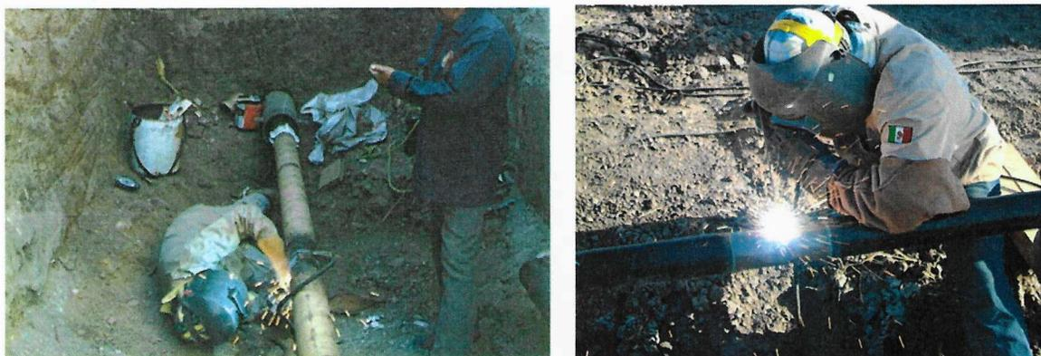
**Figura II-22. Soldado de la tubería para el gasoducto**
