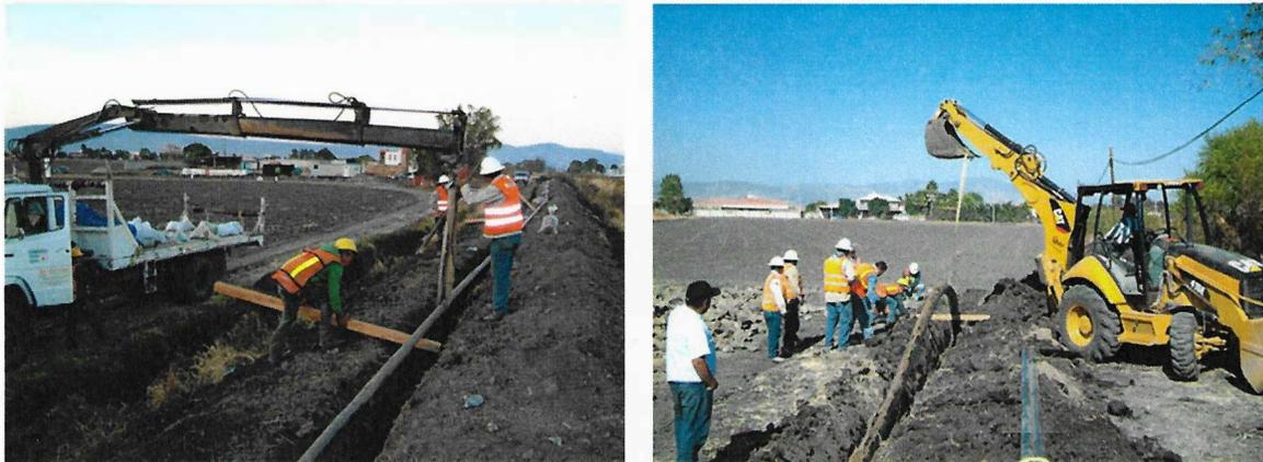
**Figura II-21. Alineado y tendido de la tubería para el gasoducto**
