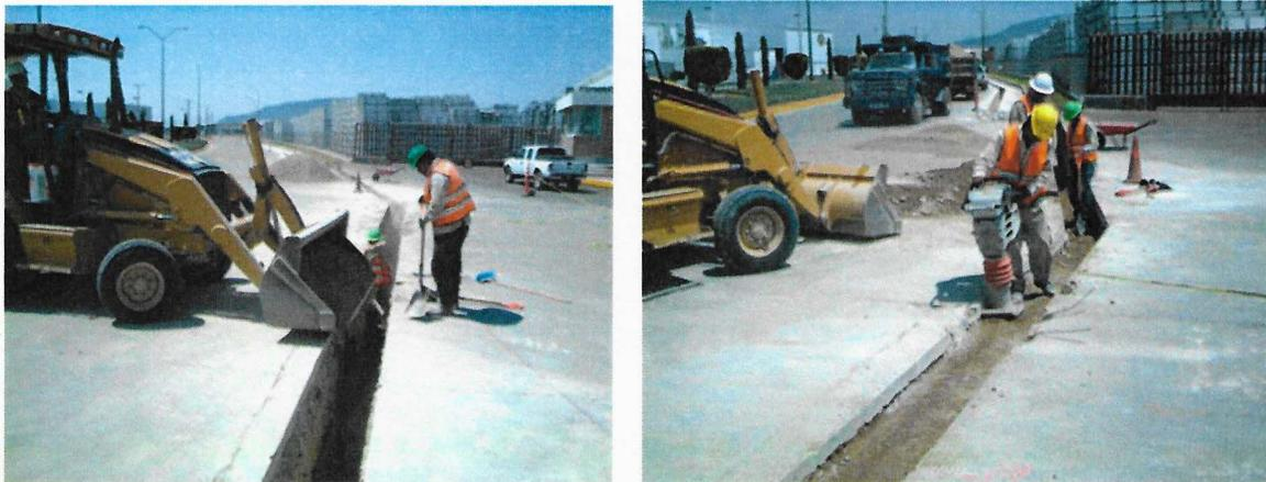
**Figura II-25. Relleno de la zanja y compactación del material**
