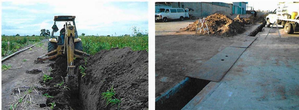
**Figura II- 18. Excavación de la zanja para el gasoducto e instalación de placas para paso**
