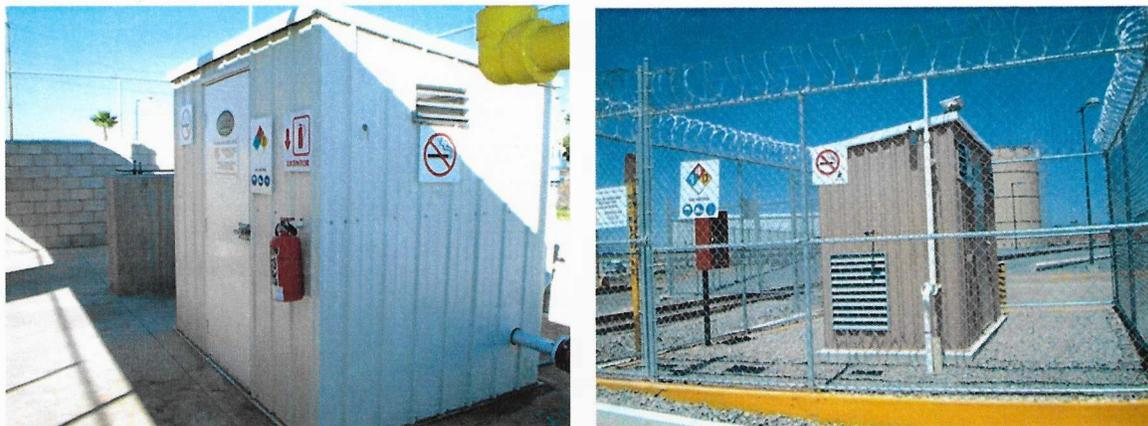
**Figura II-16. Casetas tipo de medición y regulación de usuarios de gas natural**
