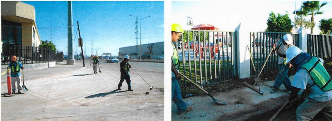
**Figura II-33. Limpieza y restitución del terreno**
