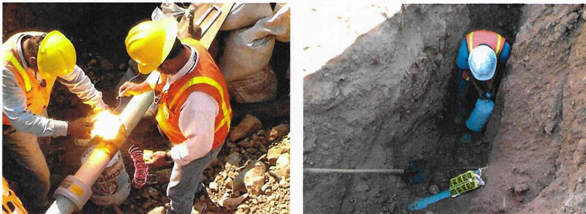
**Figura II-23. Instalación del sistema de protección contra la corrosión en el gasoducto**
