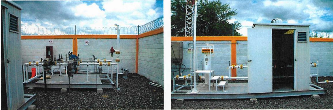
**Figura II-15. Estación principal de medición y regulación de gas natural**
