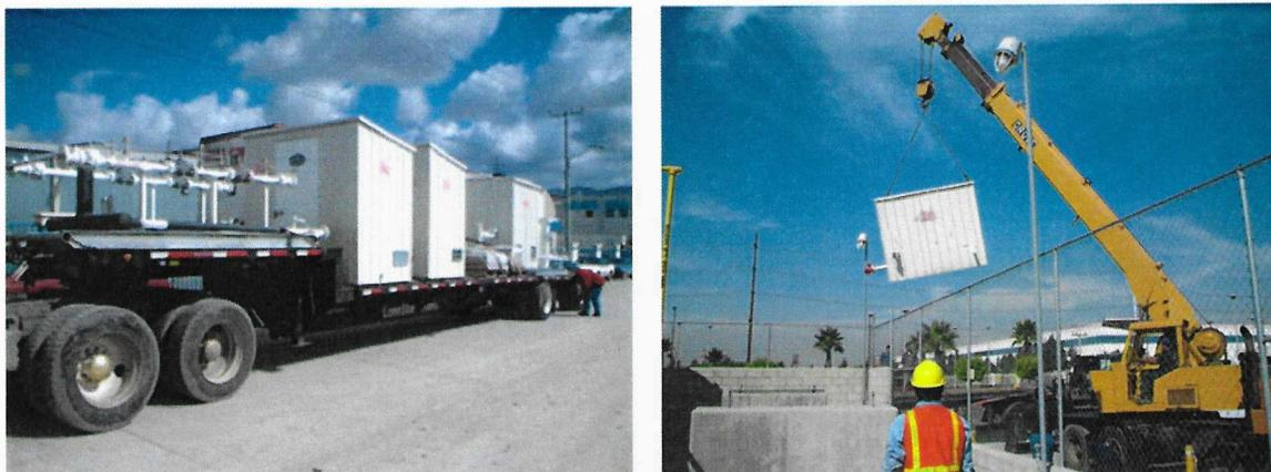
**Figura II-14. Casetas prefabricadas de medición y regulación de gas natural para usuarios**
