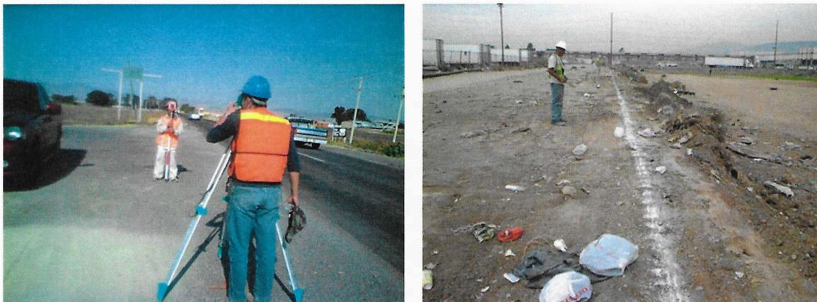
**Figura II-11. Trazo y marcaje de la ruta de un gasoducto**
