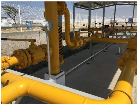
*Figura 2 Estación de regulación y medición (ejemplo)*
