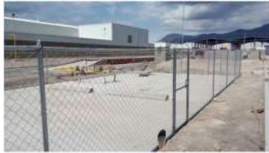
Ilustración 18. Vista hacia el Interior del Predio del Proyecto, donde se observa el limite del predio de la Planta, y la Delimitación parcial del área ocupada por la losa, mediante malla ciclónica de acero galvanizado con altura de 2 m, como se describe en el apartado I.1.1. Proyecto civil
