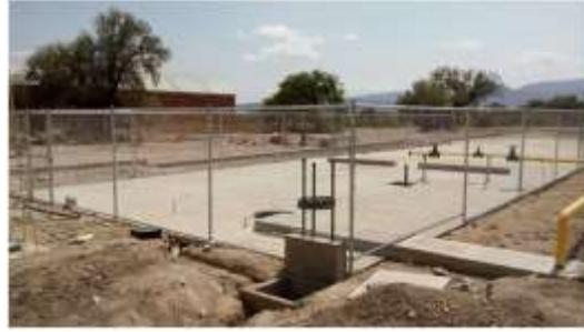
Ilustración 16. Vista desde el Exterior del predio del proyecto con dirección NNE-SO. Se observa la Delimitación parcial del área ocupada por la losa, mediante malla ciclónica de acero galvanizado con altura de 2 m, como se describe en el apartado I.1.1. Proyecto civil
