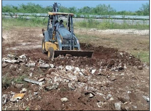
8.- Con apoyo de la retroexcavadora se extrajo el material edáfico afectado.
