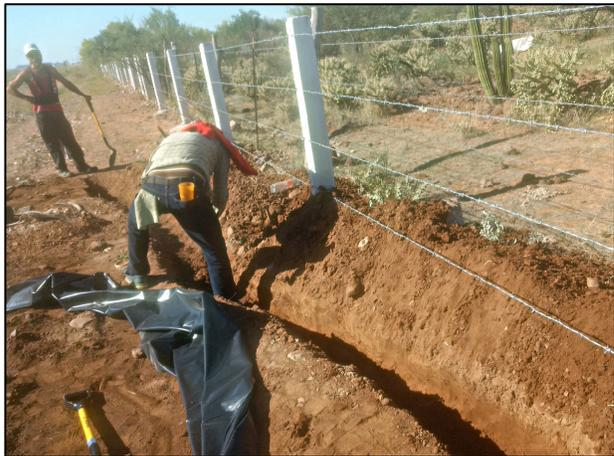
4.- Se construyó el borde de contención en la parte baja del terreno para evitar el desplazamiento horizontal del contaminante hacia predio particular.
