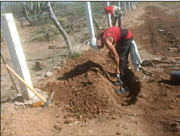
3.- Con apoyo de picos y palas se inicia la construcción del borde de contención.
