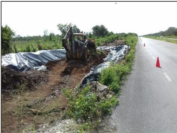
11.- Depósito del material edáfico afectado en la celda provisional.
