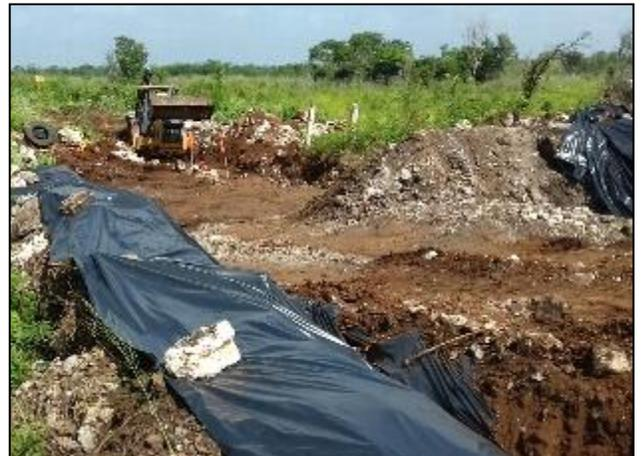
10.- Acarreo del material edáfico afectado hacia la celda provisional.
