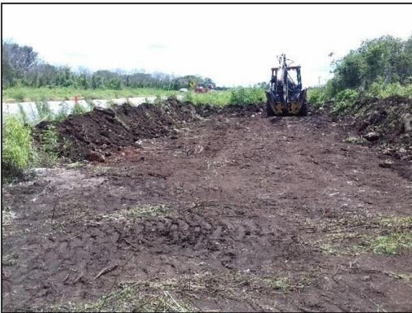
3.- Con apoyo de la retroexcavadora se acondicionó el terreno para la construcción de la celda provisional.
