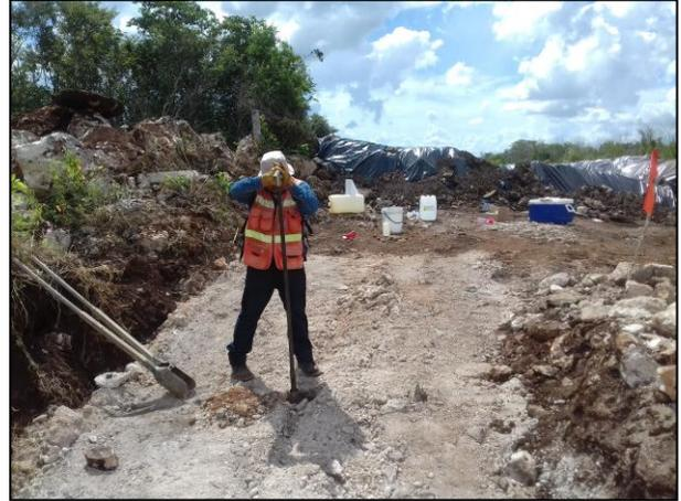
8 – Con ayuda del Hand Auger se tomaron muestras en el fondo de la fosa de excavación.
