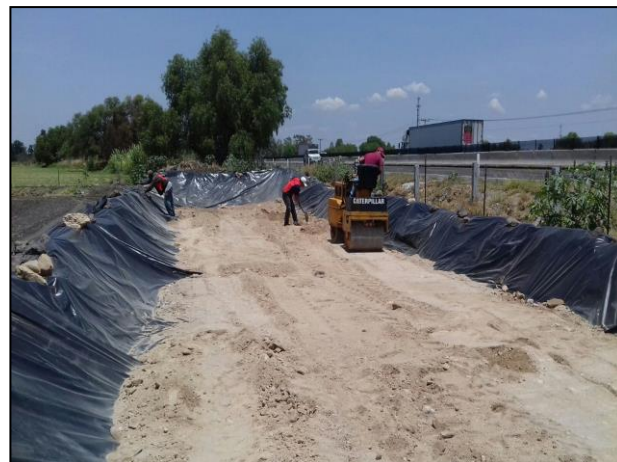
6.- Con el apoyo de vibrocompactador, se compacto la capa de arcilla colocada.
