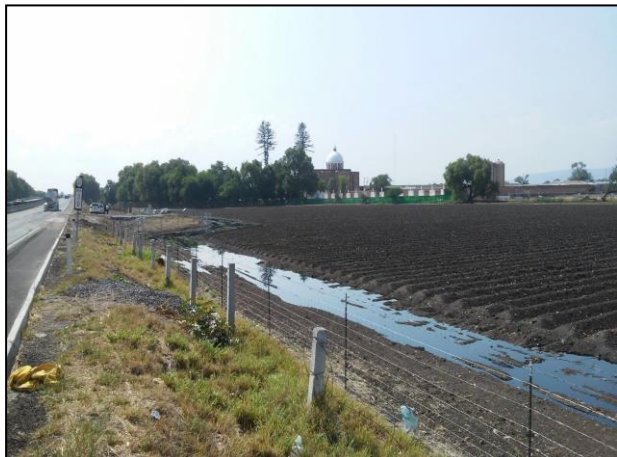
1.- Ubicación del sitio del accidente en el Km. 030 + 000 de la Carretera (2170) Querétaro - Irapuato (Directo), tramo Querétaro Irapuato, municipio de Apaseo el Grande, estado de Guanajuato.
