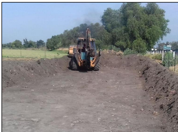
3.- Se construyeron los bordos de la celda provisional con ayuda de la retroexcavadora
