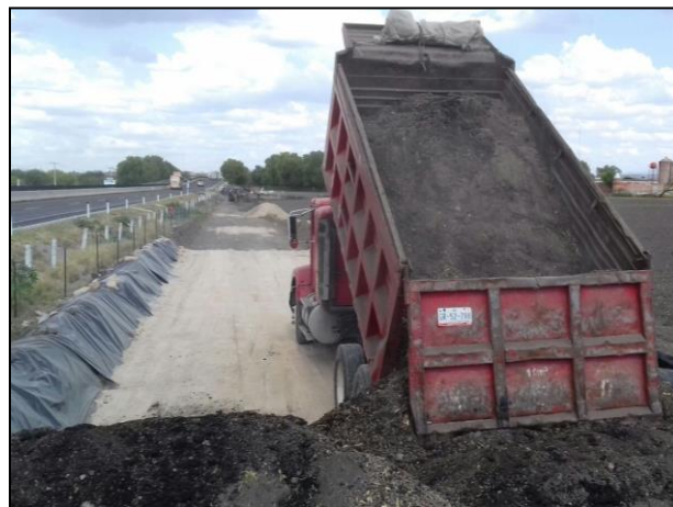
10.- Se depositó el material edáfico afectado en la celda provisional.
