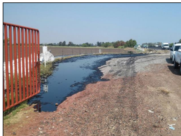
6 Se afectó parte del sello carretero (areno-grava, tezontle y suelo natural) de la entrada al rancho "El Mayorazgo".
