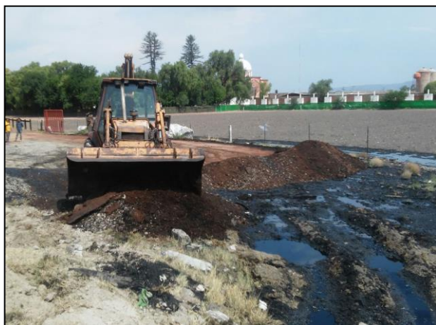
11.- Se realizó la limpieza de la entrada del rancho "El Mayorazgo" retirando el material compuesto de areno-grava, tezontle y suelo natural afectados.
