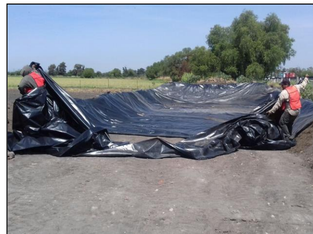
4.- Se cubrieron los bordos con una película de polietileno de alta densidad.
