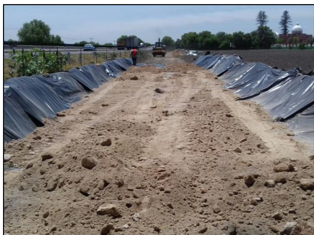
5.- Se colocó una capa de arcilla sobre el polietileno de alta densidad para aumentar la impermeabilidad de la celda provisional.
