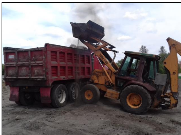
9.- El material edáfico afectado se depositó en un camión de carga con ayuda de maquinaria pesada para su traslado a la celda provisional.
