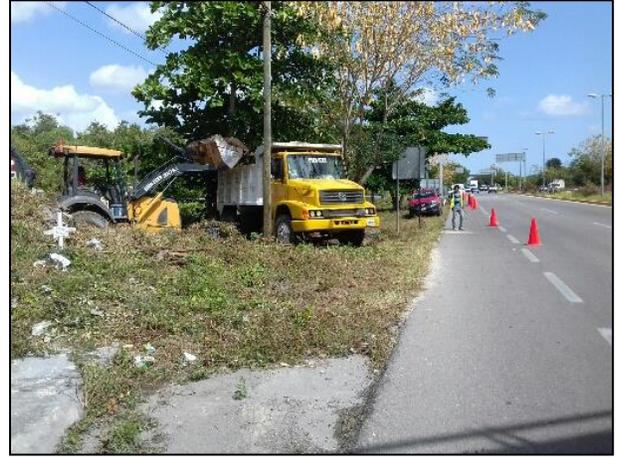
12 – El material afectado se depositó en un camión de carga con ayuda de maquinaria pesada para trasladarse a la celda provisional.
