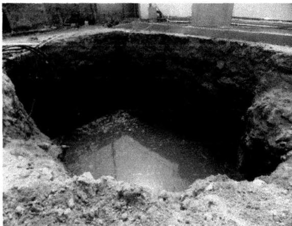
Figura 0-3 Fosa para la instalación del tanque de diésel
