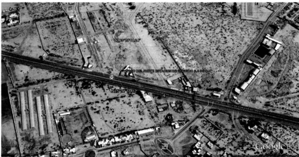
Figura 1.-La estación de servicio de Pemex, se encuentra en la ciudad de Torreón, en el estado de Coahuila
