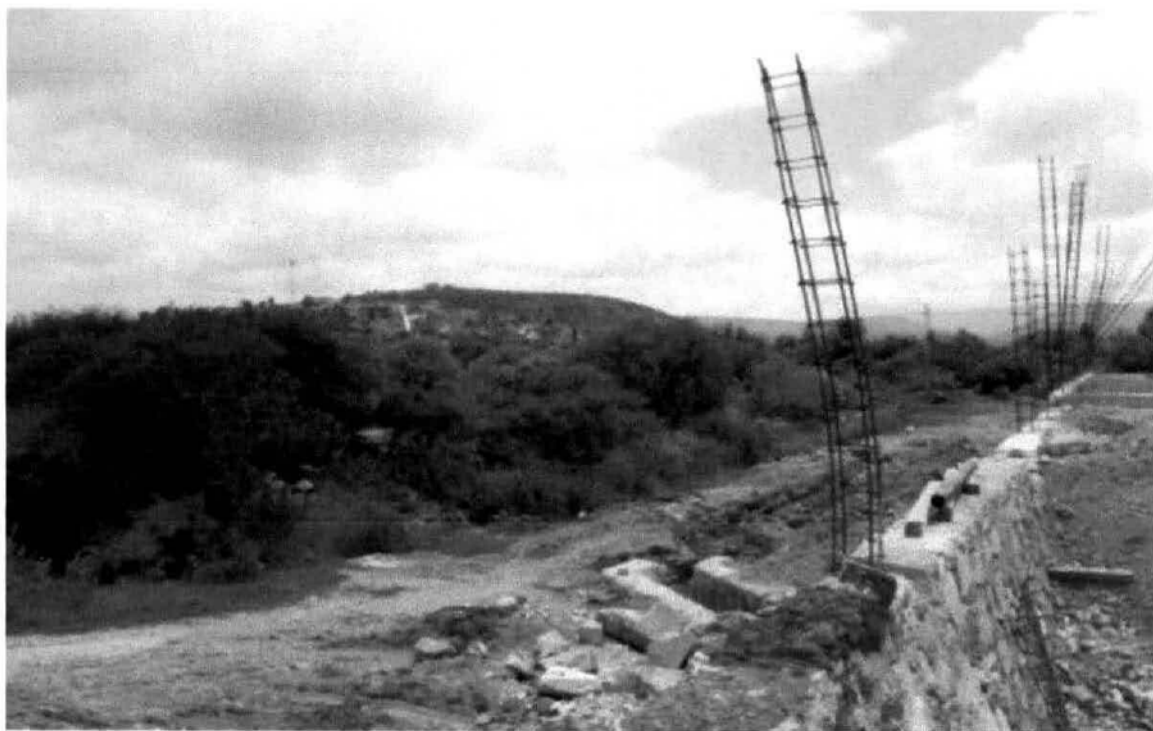
Fotografía 5. Colindancia oeste del terreno
