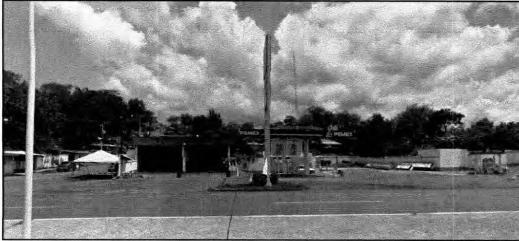
Imagen II.1 Vista frontal de la Estación de Servicios “Quesería”.
