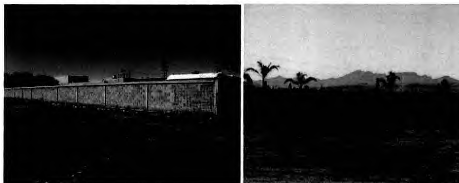
Figura 2. Colindancia Norte con barda Perimetral y predio con actividades comerciales (venta de alimentos) y Colindancia Poniente con predio sin uso
