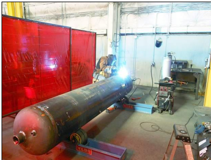
Figura 2.7. Ejemplo de tuberías.
