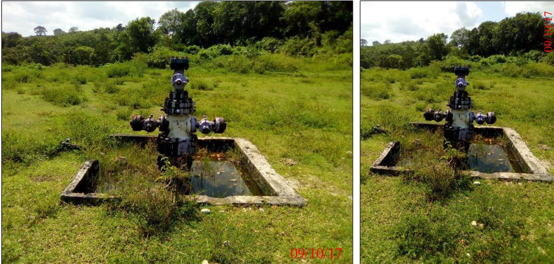
El área perimetral al pozo Gutiérrez Zamora 4 no presenta afectaciones superficiales que pudieran comprometer el medio ambiente, sin embargo, la válvula maestra y el cabezal de producción se aprecian impregnados de hidrocarburo.
