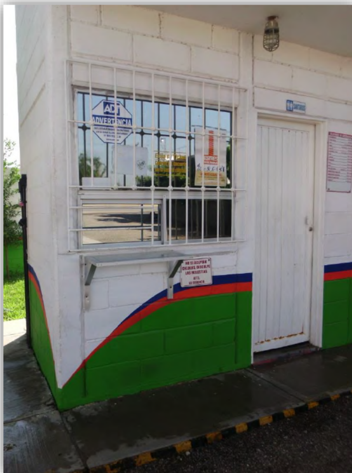
FIGURA 4: Oficina ubicada dentro de la Estación de Servicios “Guamúchil Sur”
