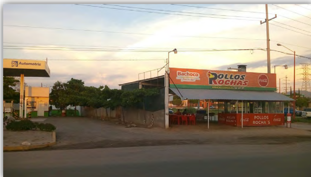
FIGURA 15: COLINDANCIA SUR Blvd. José María Morelos antes canal de conducción (negocio comercial)
