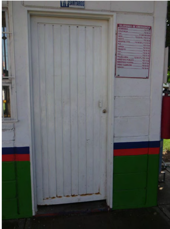
FIGURA 5: Sanitario ubicada dentro de la Estación de Servicios “Guamúchil Sur”
