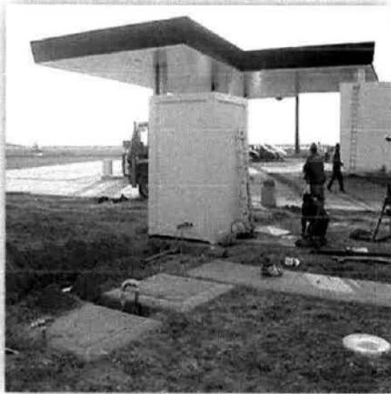
Imagen 14. Líneas de drenaje independientes para la conducción del agua pluvial, sanitaria y aceitosa.
