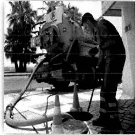
Imagen 15. Remoción de residuos combustibles, grasas y aceites para evitar contaminación del cuerpo receptor.
